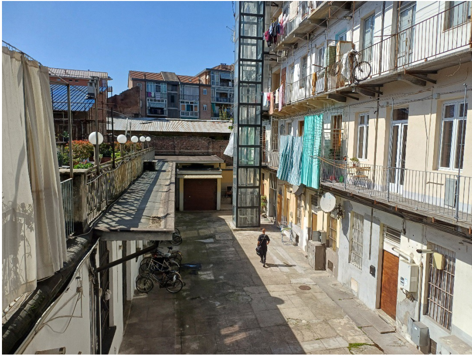
Foto 5 – Cortile con torre ascensore
