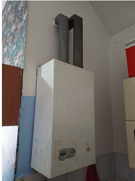
Foto 14 – Caldaia a gas
