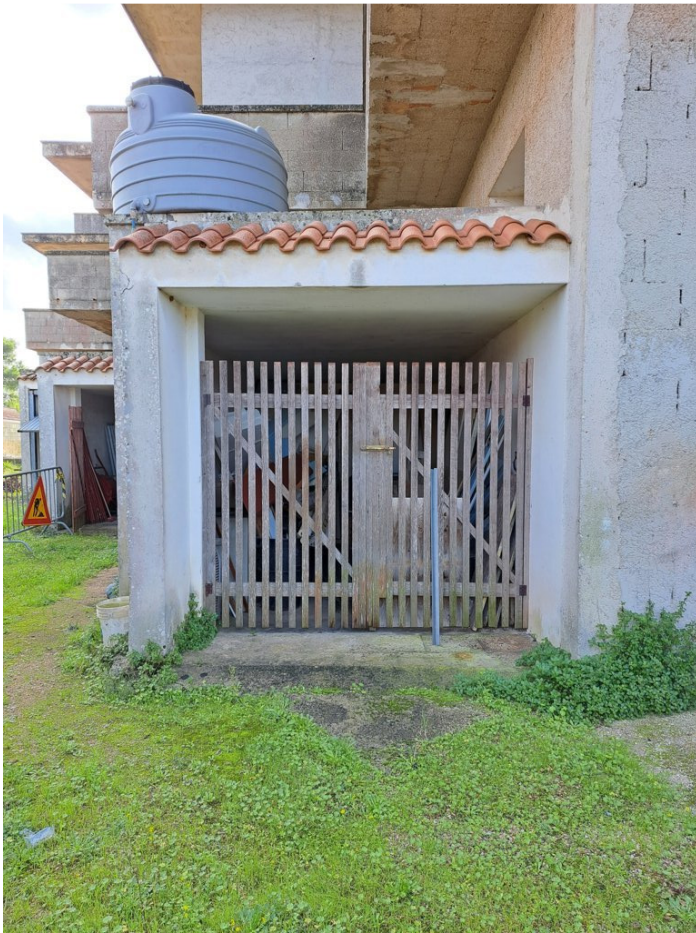
LOTTO 4 Piano Terra box garage (sub. 10)
