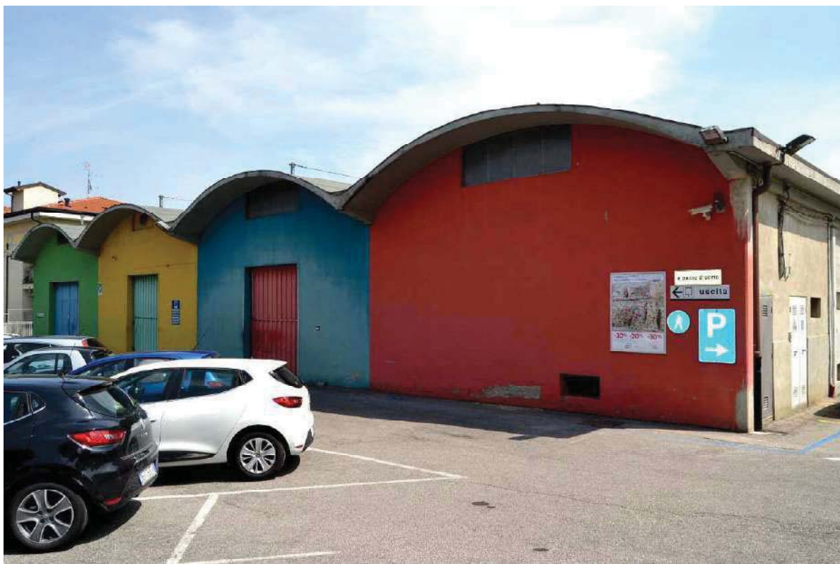
09. FRONTE NORD - DEPOSITI
