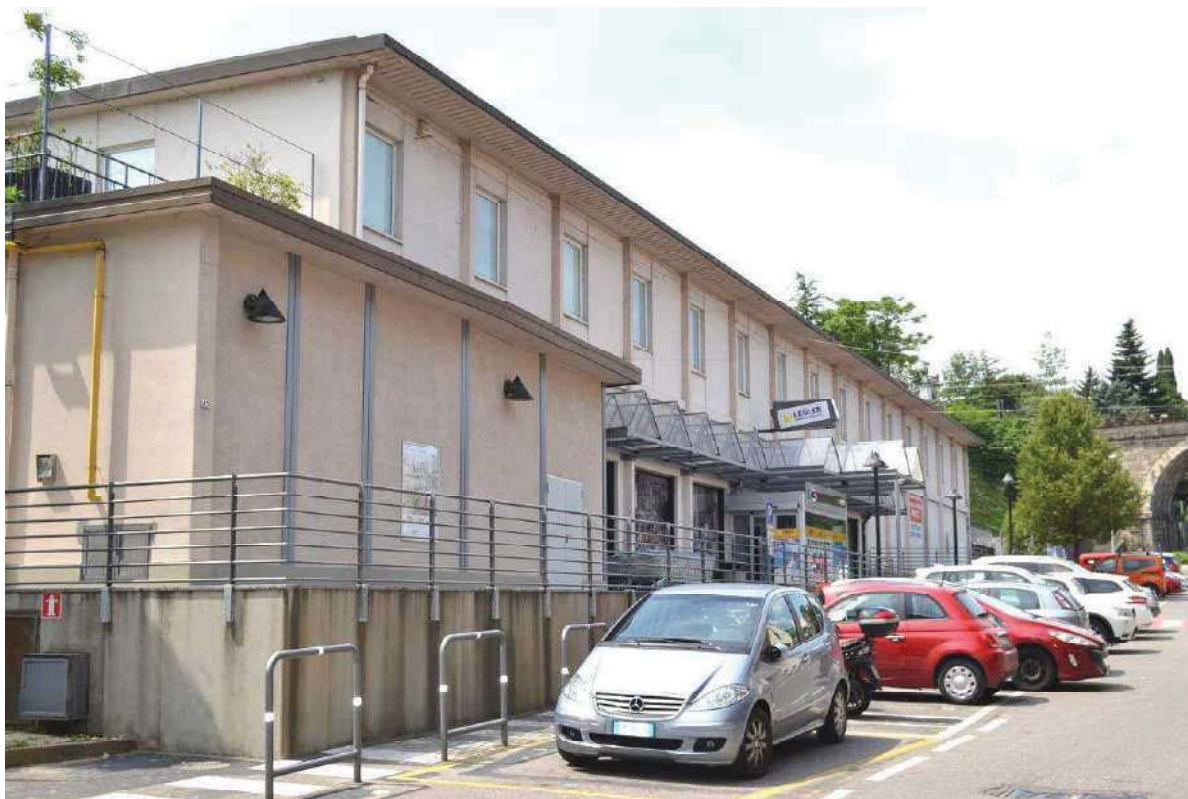
01. FRONTE EST – INGRESSO IMMOBILE
