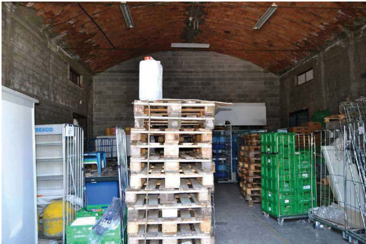
11. INTERNO DEPOSITO GIALLO – PIANO TERRA
