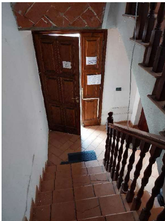
vano scala che distribuisce le varie unità abitative
