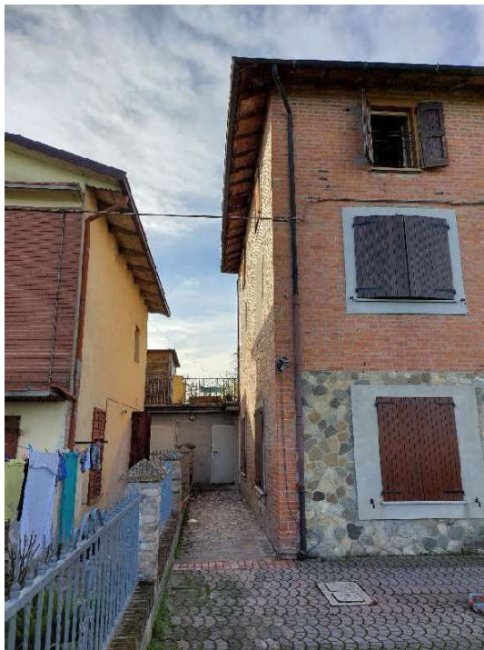
Angolo Est – passaggio esterno che conduce alle cantine
