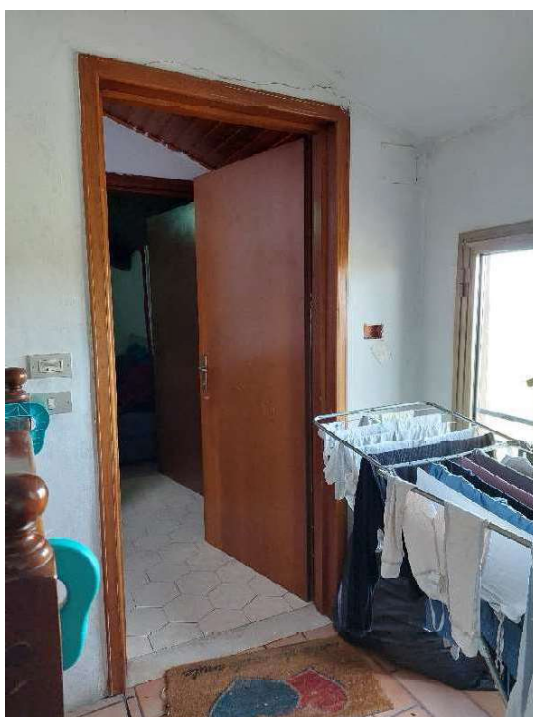
Piano 2 sottotetto - Ingresso all'unità abitativa oggetto di pignoramento
