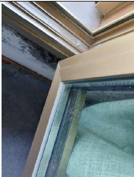
Infisso esterno in alluminio anodizzato con vetro doppio
