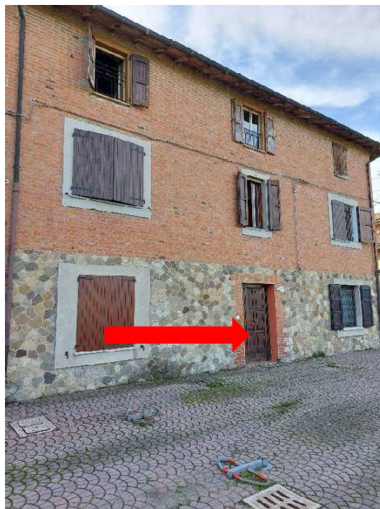
Ingresso al vano scala
