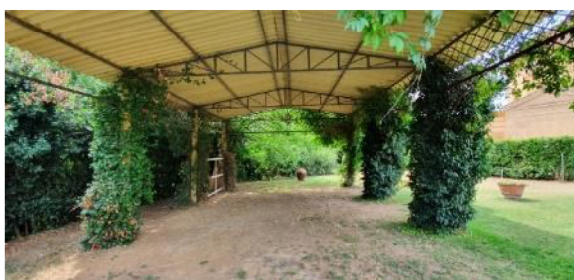
Immagine 13 Vista della tettoia
