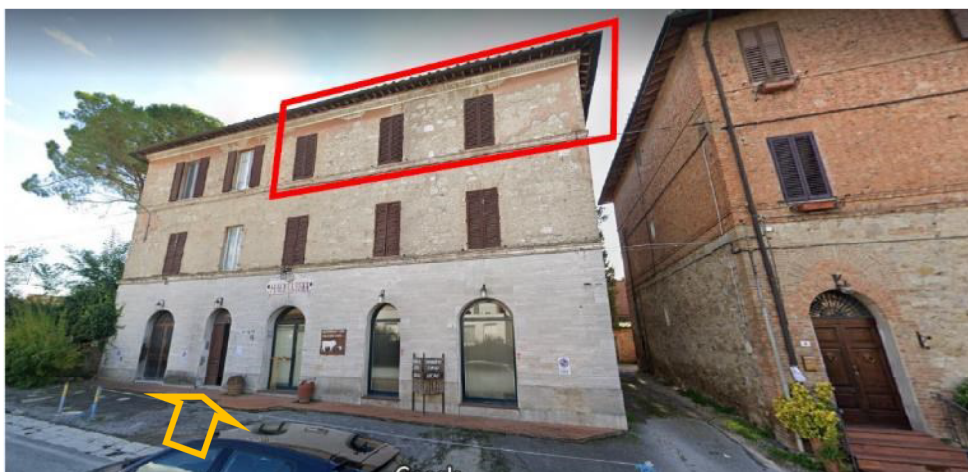
Immagine 17 Vista da via Aretina del fabbricato con evidenziazione beni lotto 2 (sub.7)
