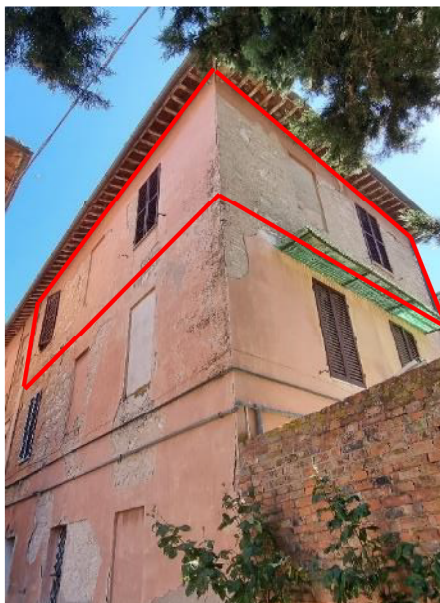
Immagine 19 Vista da vicolo interno beni lotto 2 (sub. 8-sul retro)
