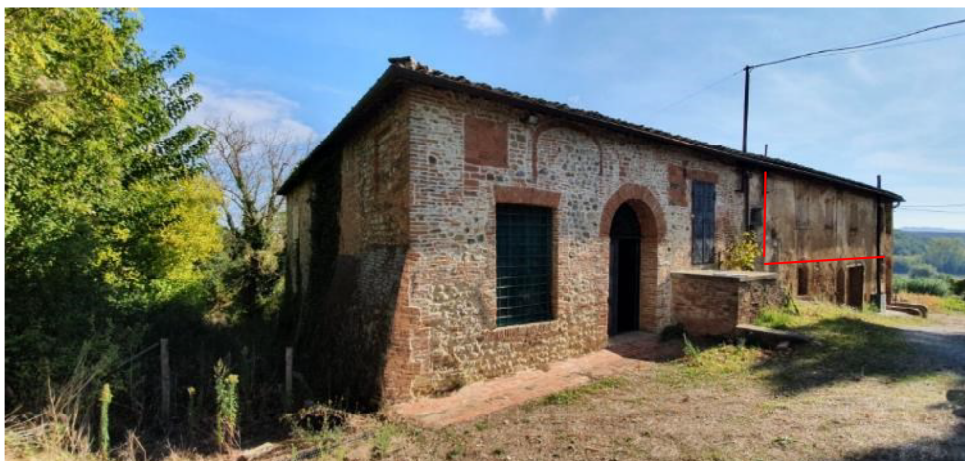
Immagine 8 Vista della porzione di fabbricato rurale adibito a cantina
