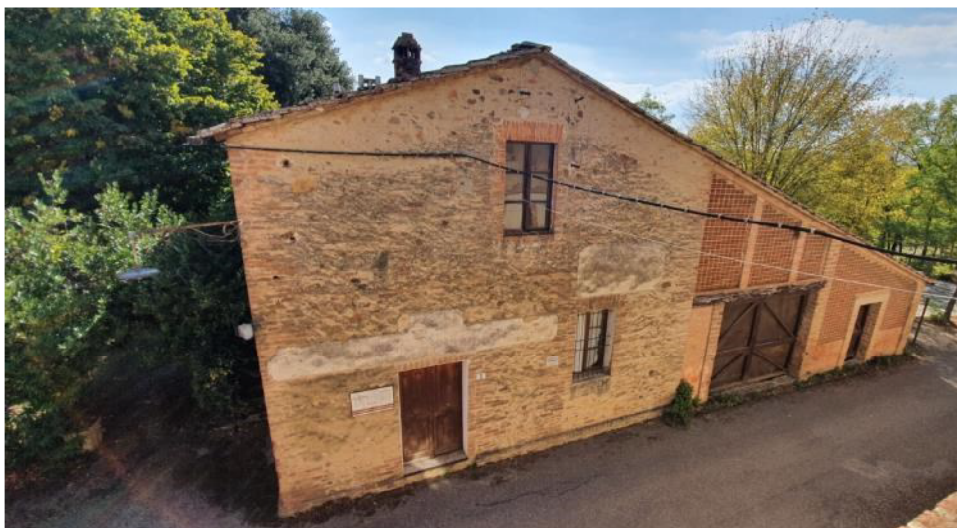
Immagine 7 Vista del fabbricato rurale dal lato a nord-ovest
