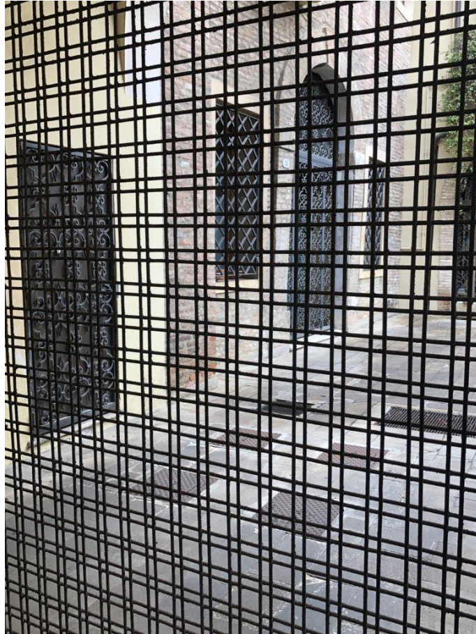
foto n. 3 –facciata sud su cortile
