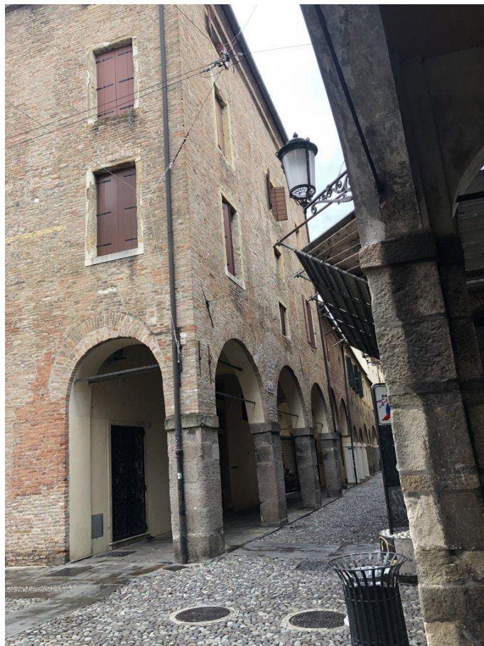
foto n. 2 – angolo nord-ovest con via Boccalerie
