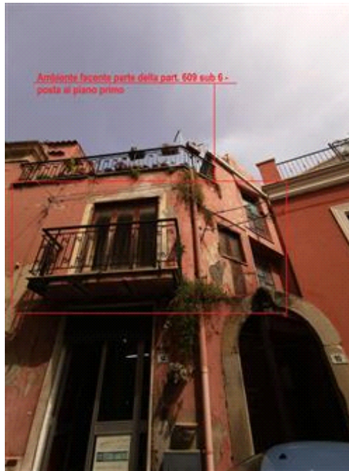
Foto particella 609 sub 6 - Piano Primo
