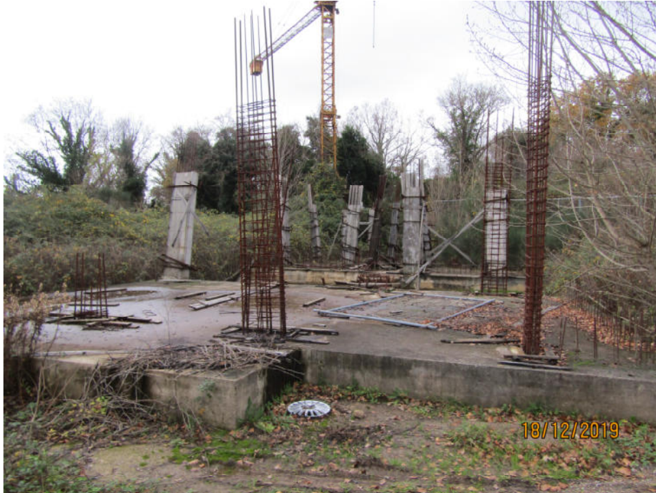
Loc. Le Cetine, Sassofortino - Foglio 77 Particella 127
