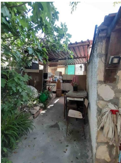
Foto 14 – Tettoia adiacente al Fabbricato
