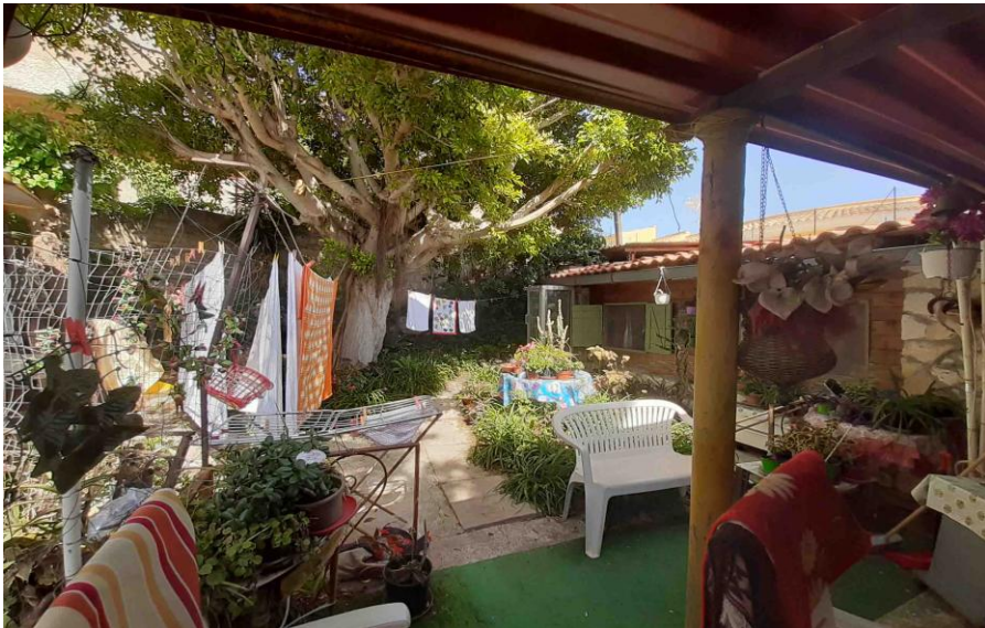
Foto 12 – Tettoia antistante il fabbricato
