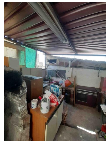
Foto 17 – Zona forno esterna
