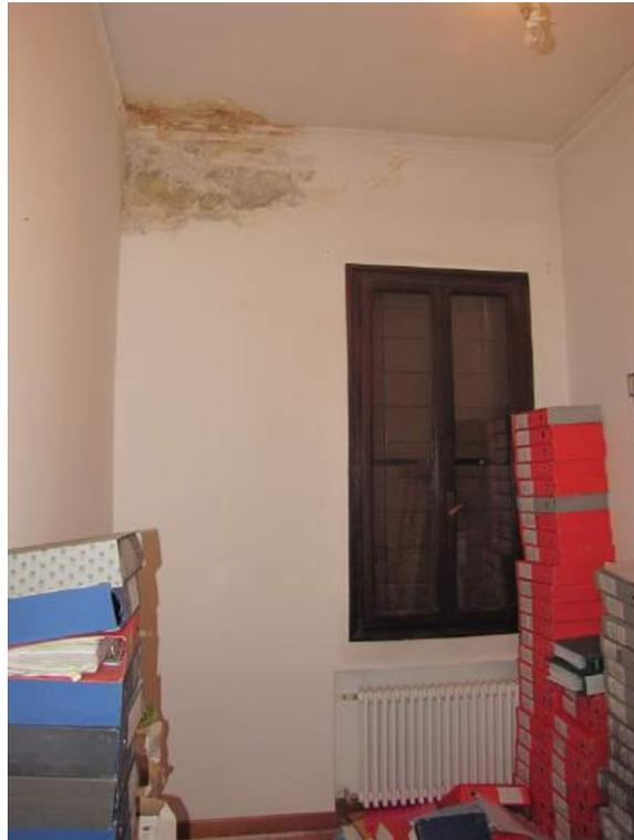
Camera al Piano Primo con macchie di umidità nel soffitto
