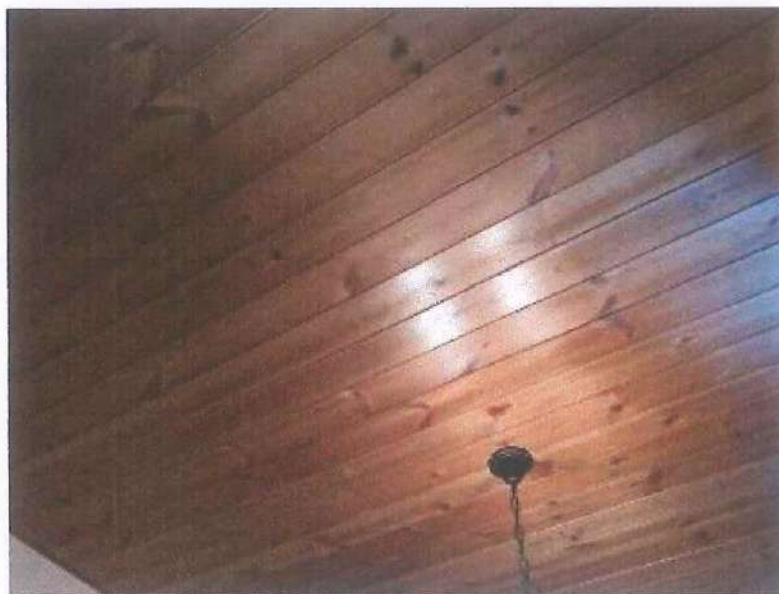
FOTO 23– Controsoffitto in legno
