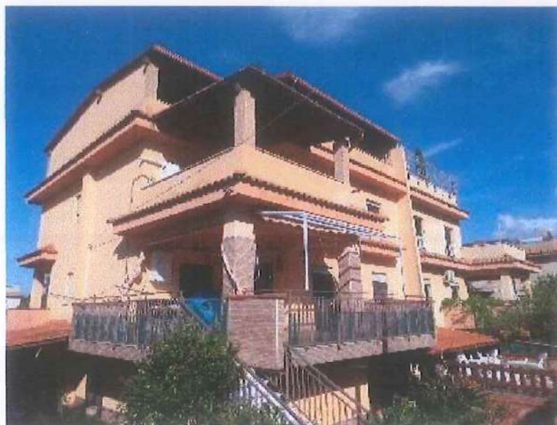
FOTO 3 – Prospetto laterale fabbricato
