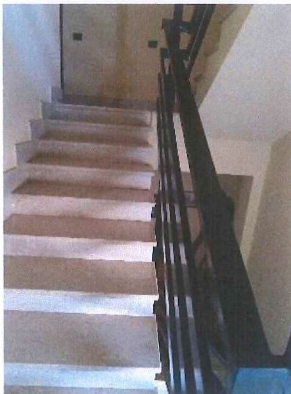
FOTO 6 – Rampa di scale con ringhiera in ferro
