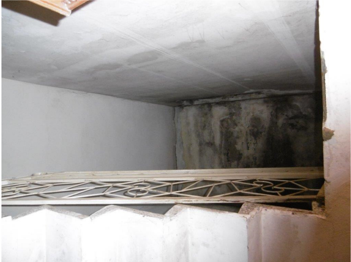
INTERNO infiltrazione scala - ESTERNO ripostiglio
