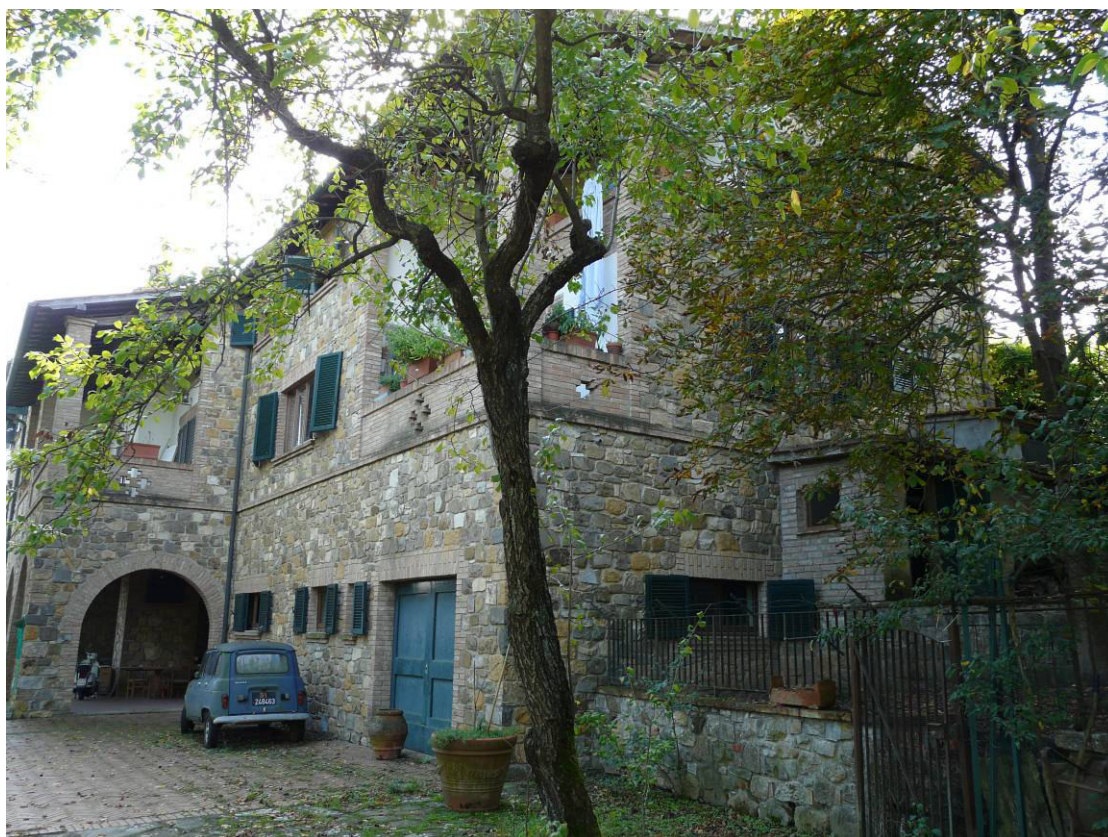
20-prospetto tergale del fabbricato
