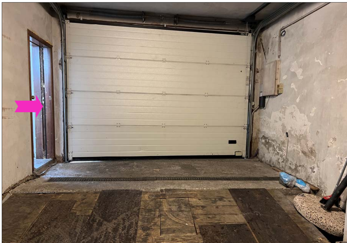
Vista dei magazzini 02-01 dal magazzino 03
