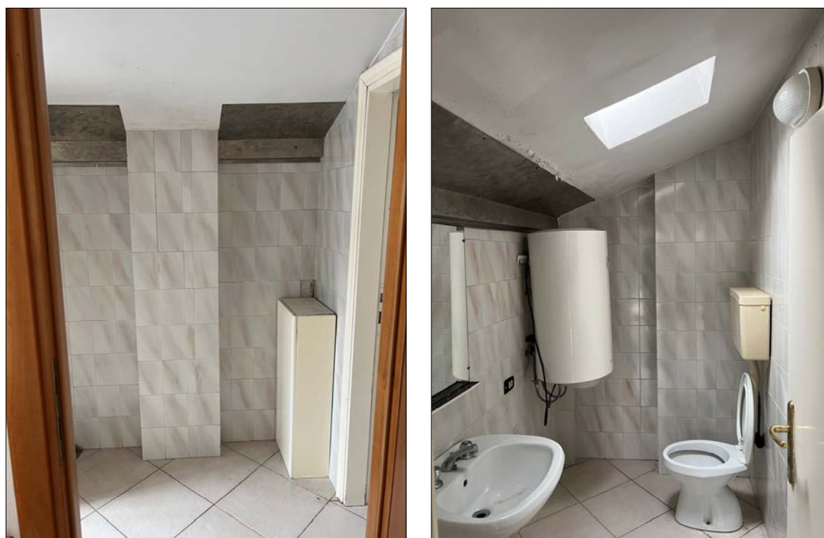
A Sx: rifodera presente nell'antibagno; a Dx: abbaino non autorizzato
