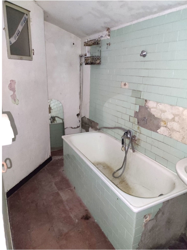
9. Bagno, piano ammezzato
