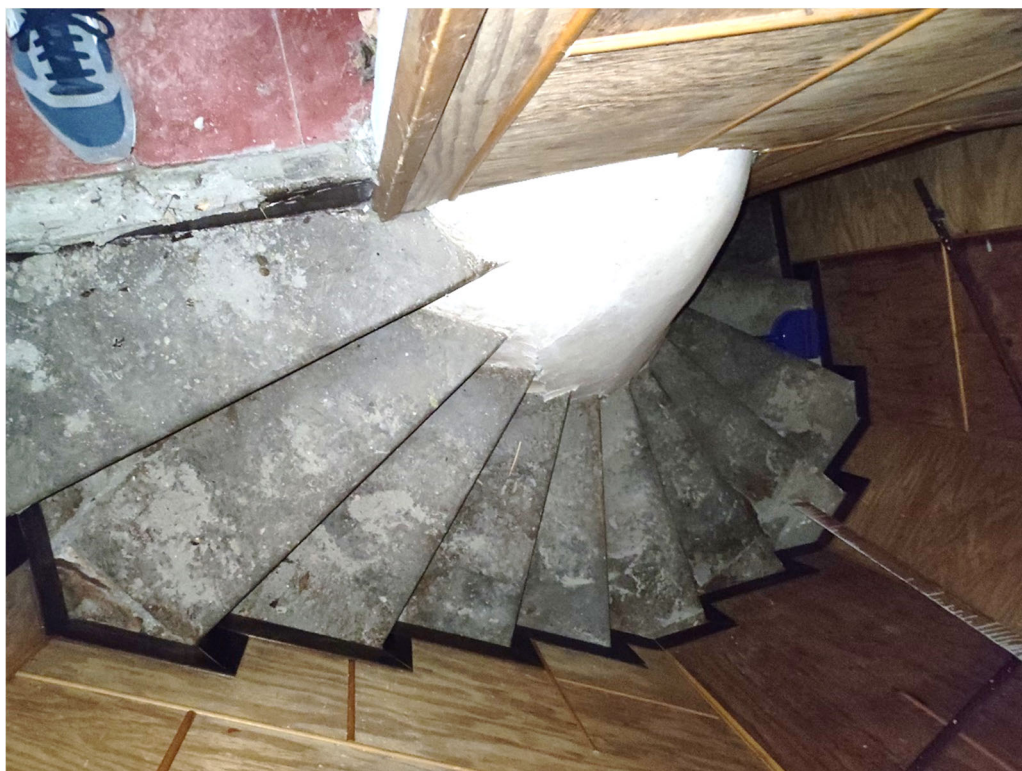
8. Scala interna di accesso al piano ammezzato
