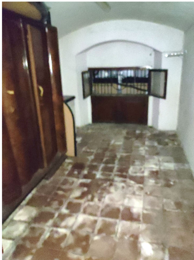
10. Ripostiglio, piano ammezzato
