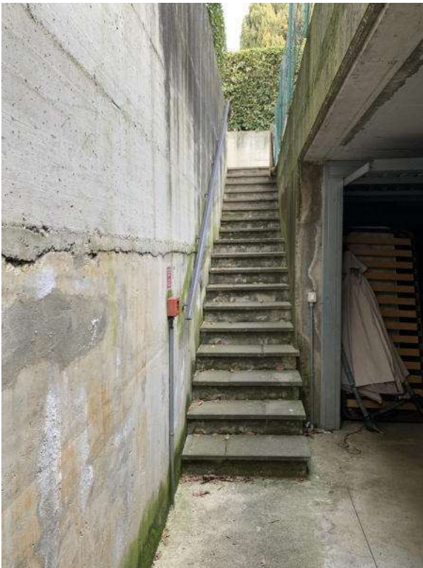
Scala nel giardino di collegamento al P. Int.
