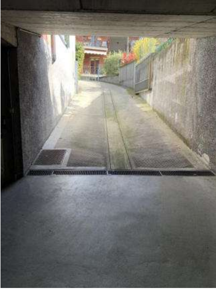
Rampa Accesso P. Int.
