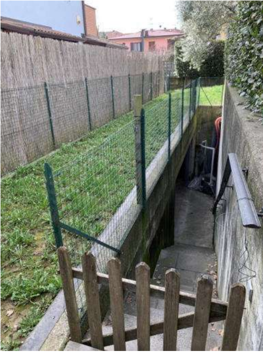
Scala in giardino di collegamento al P.Int.
