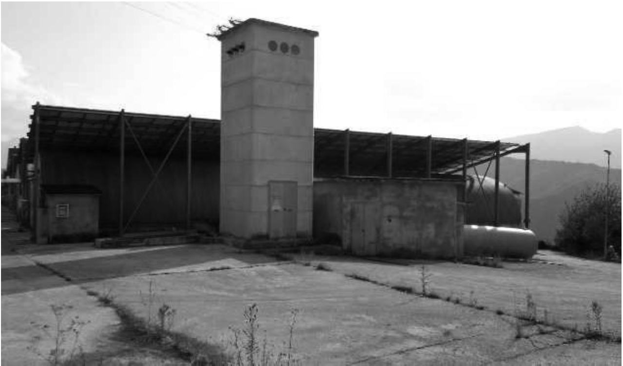
Postazione D : cabina elettrica + centrale termica
