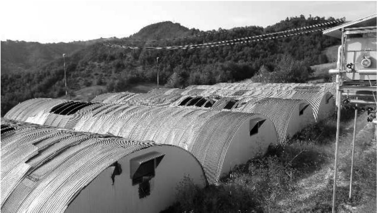
Postazione C : serre ad uso magazzino ( danneggiate )
