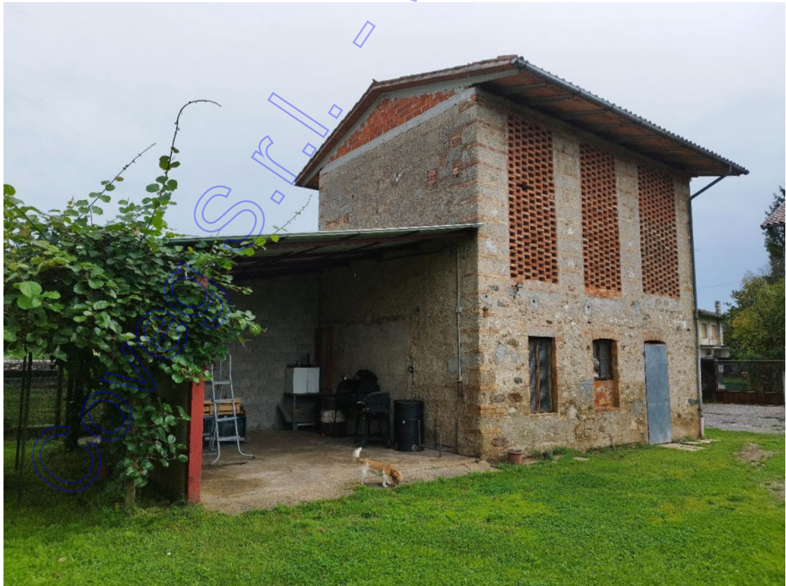
Particolari fabbricati pertinenza sub. 8
