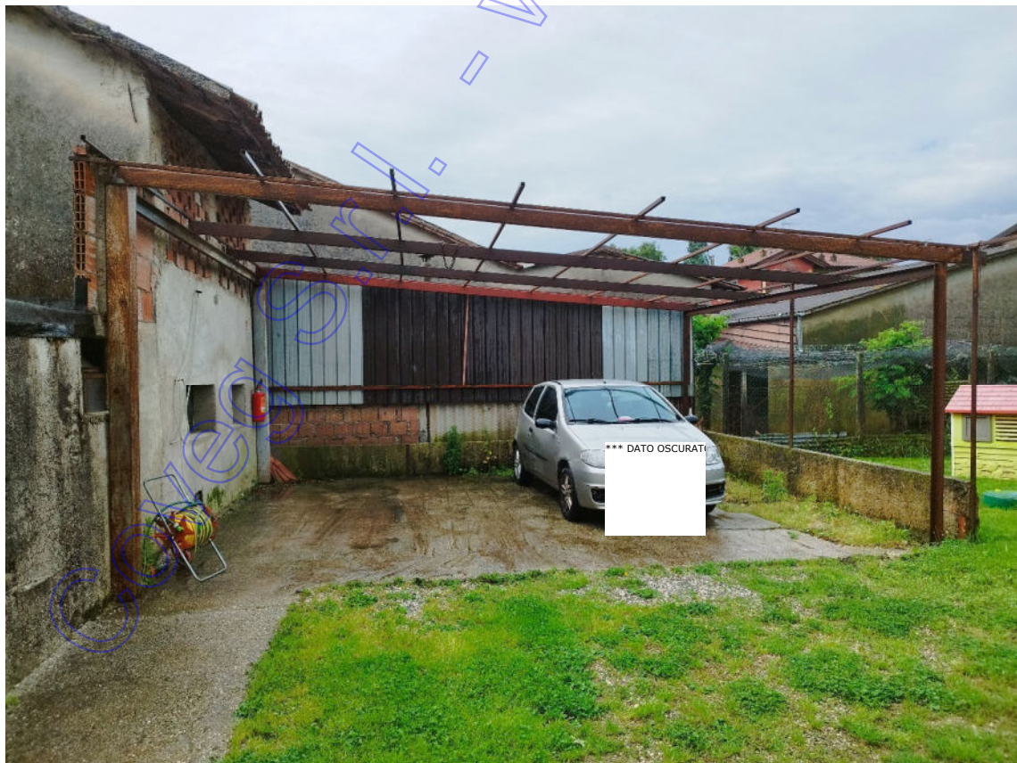
Particolari fabbricati pertinenza sub. 6
