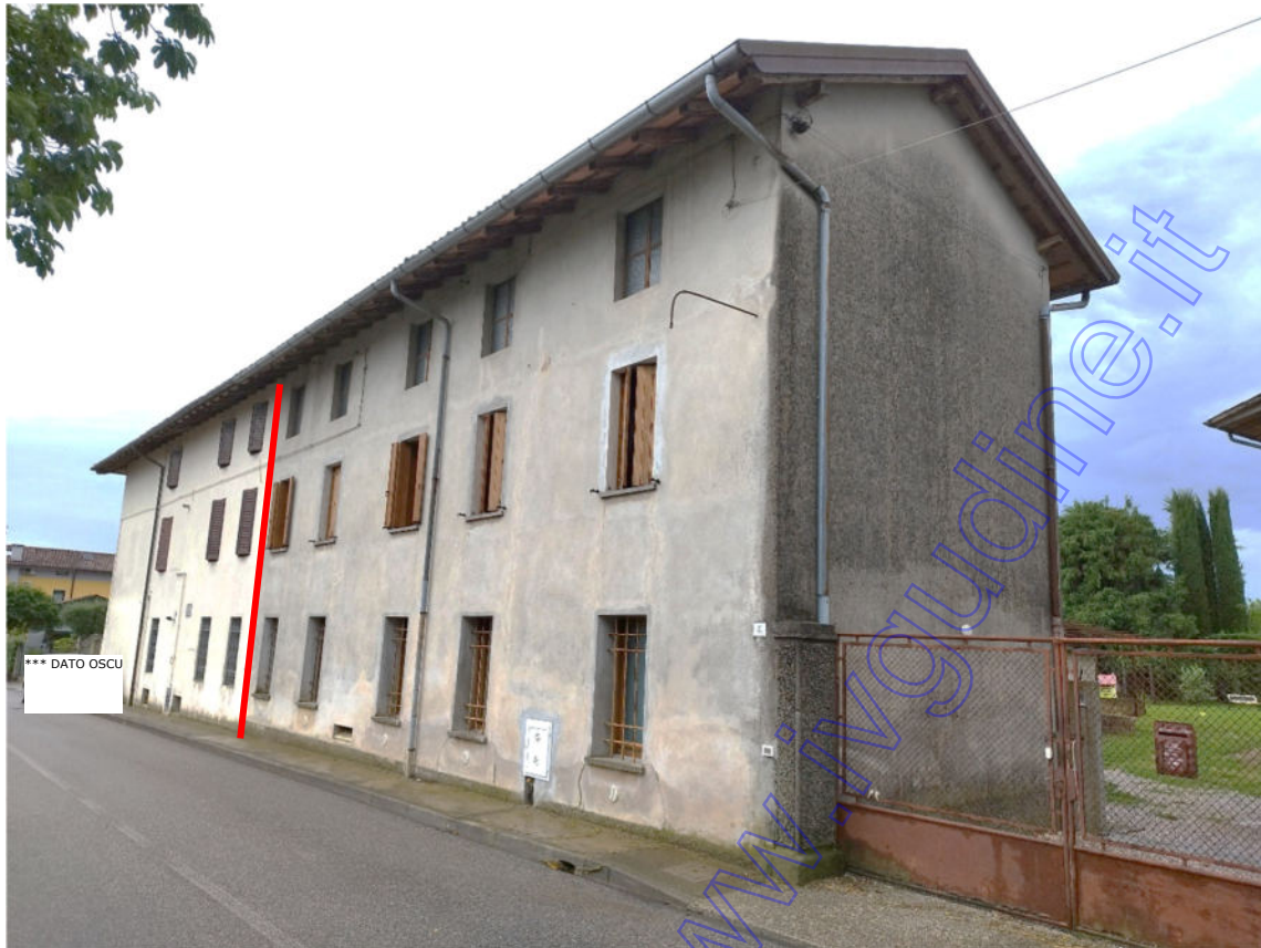
Particolare prospetto su strada pubblica (via Casali Lavia)
