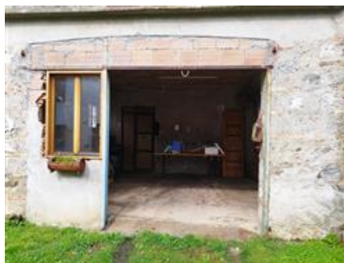
particolare ingresso PT
