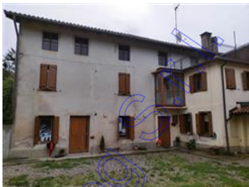
prospetto su corte interna
