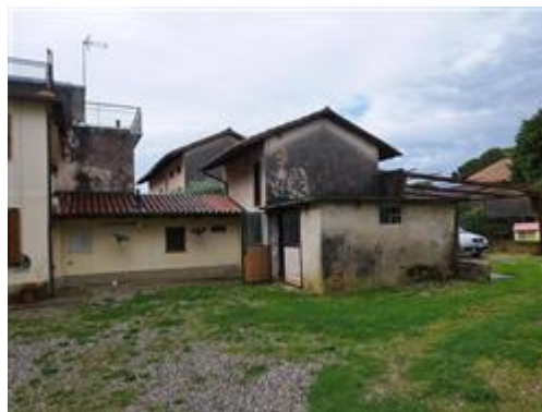
prospetto su corte interna
