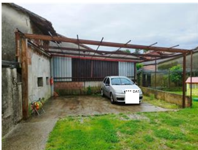
particolare posto auto scoperto
