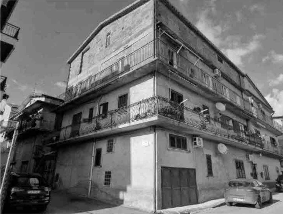
Mazzarino via Luigi Pirandello 42. Prospetti sud ed ovest del fabbricato. Immobili eseguiti a primo, secondo e terzo piano
