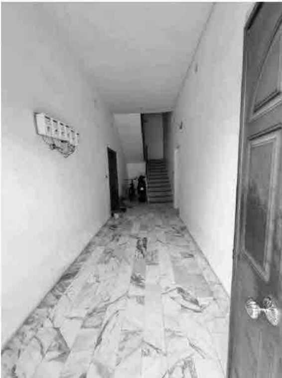
Vano scala a piano terra
