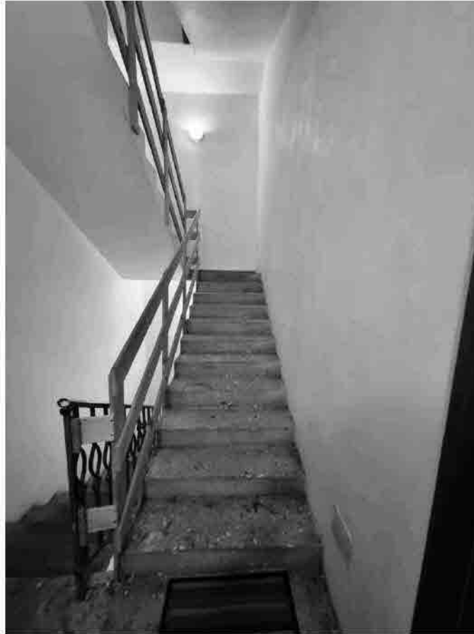
Rampa scala tra primo e secondo piano
