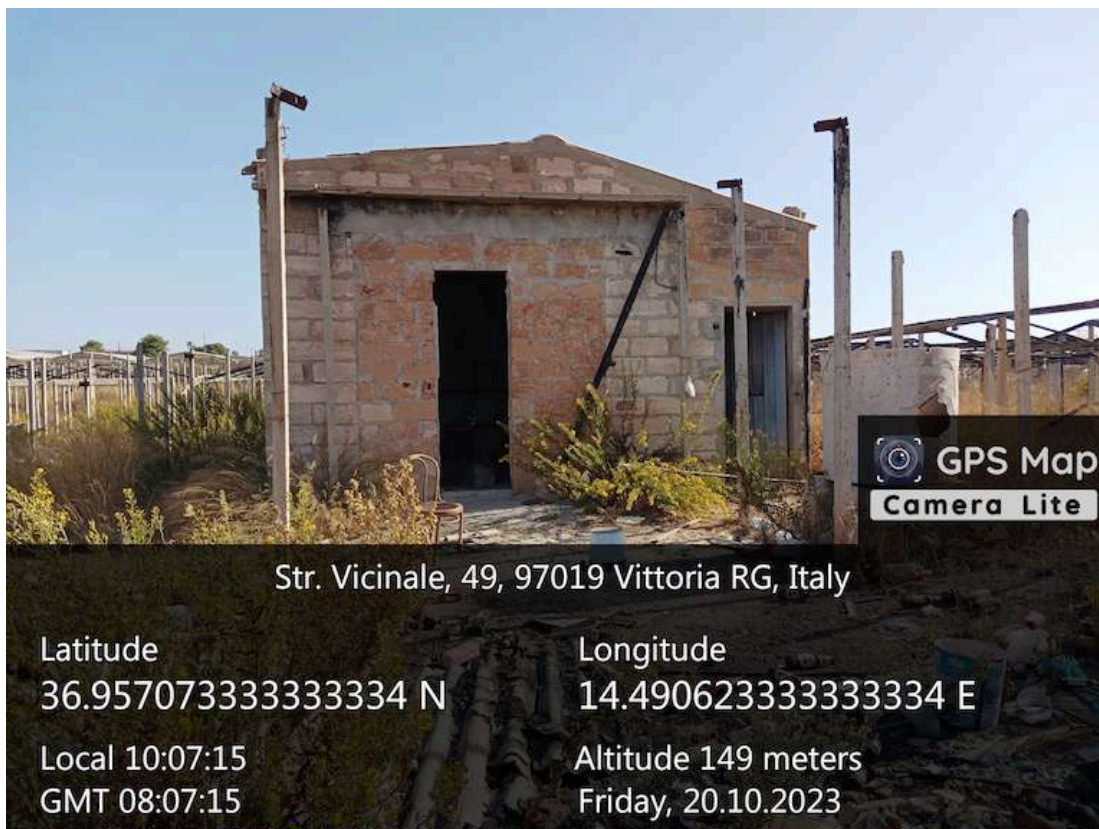
Foto 17 – Lotto unico Deposito cat. D10 particella 496.
