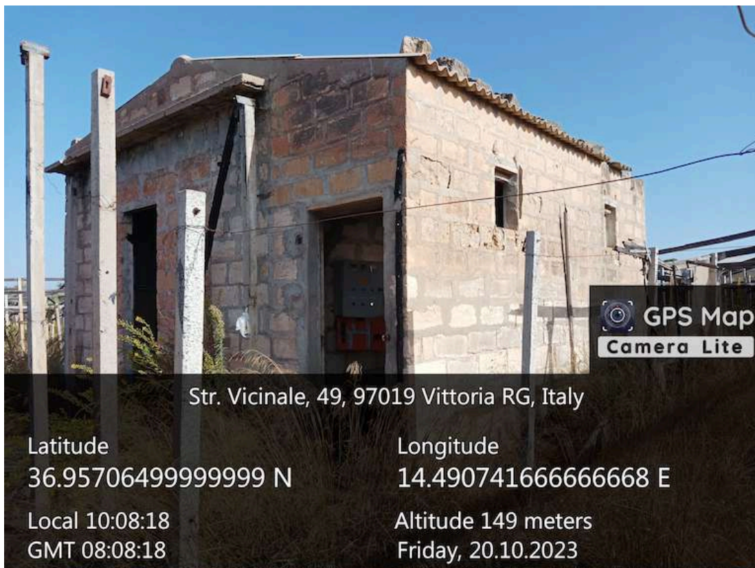
Foto 19 – Lotto unico Deposito cat. D10 particella 496.
