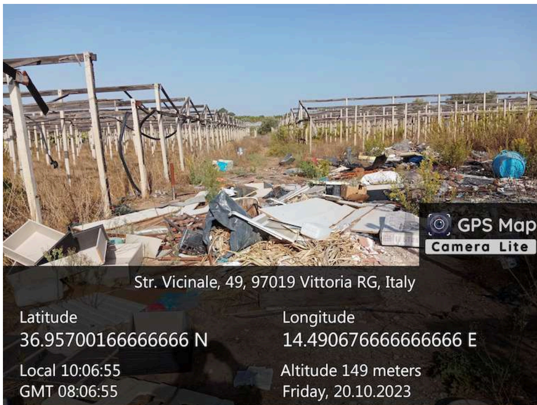
Foto 15 – Lotto unico Corte fabbricato particella 496.
