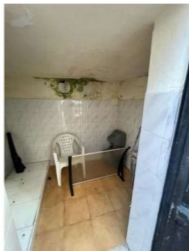
Foto 13. Vista interna locale tecnico
