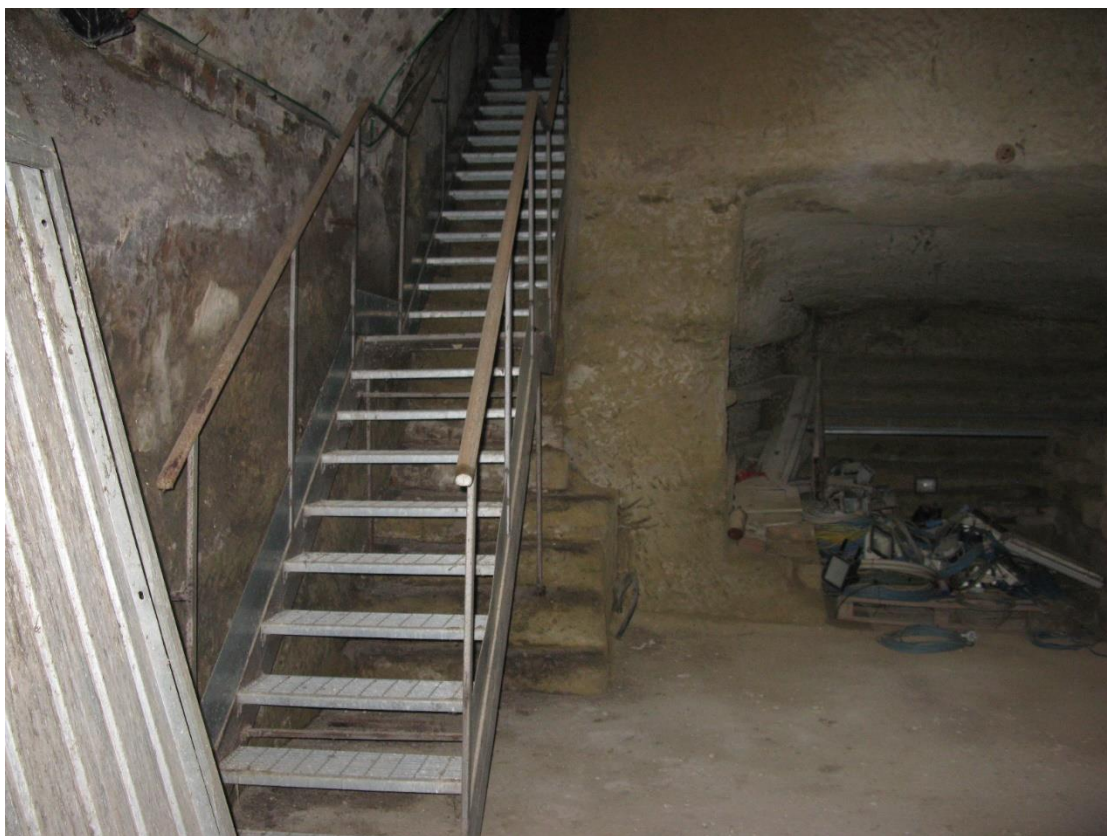
Foto 39 – Scala di accesso al piano terreno del locale dichiarato sala riunione
