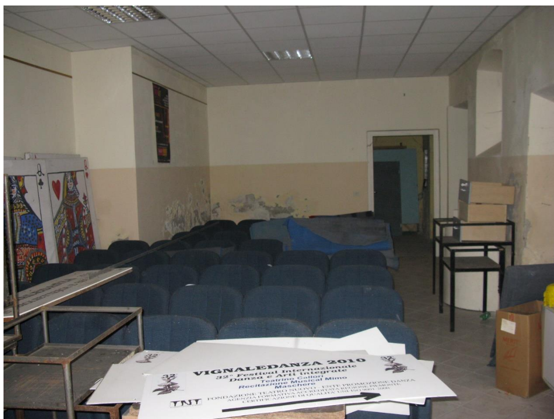
Foto 14 – Sala riunioni piano terreno
