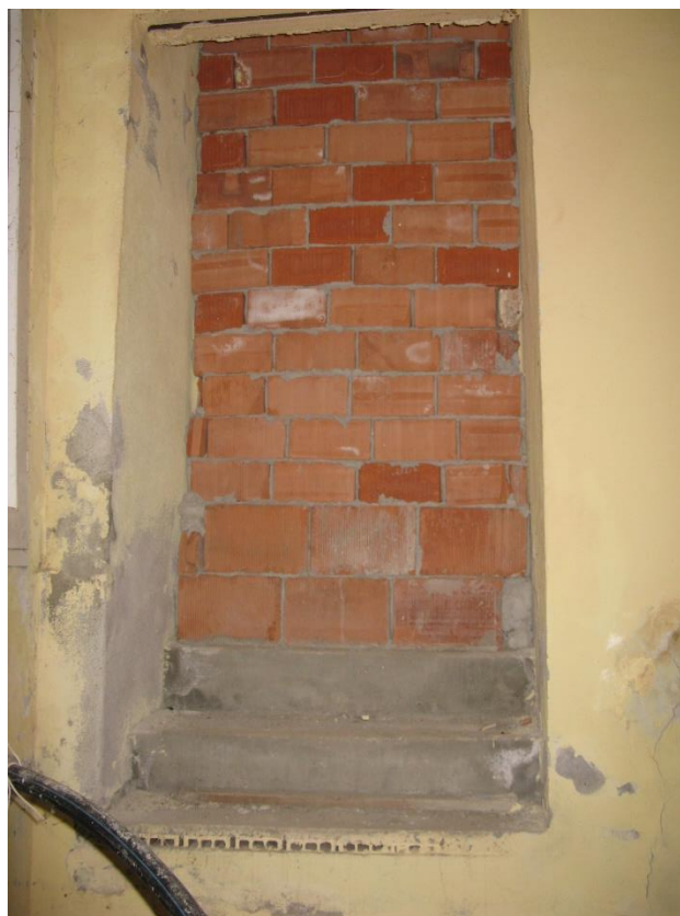
Foto 13 – Porta murata di accesso al vestibolo della Chiesa dei Battuti
