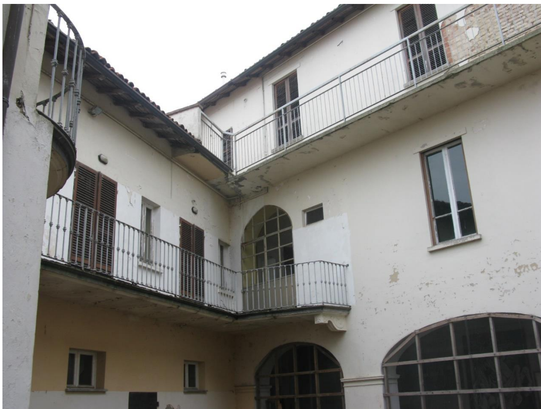
Foto 5 – Facciata ovest interno cortile
