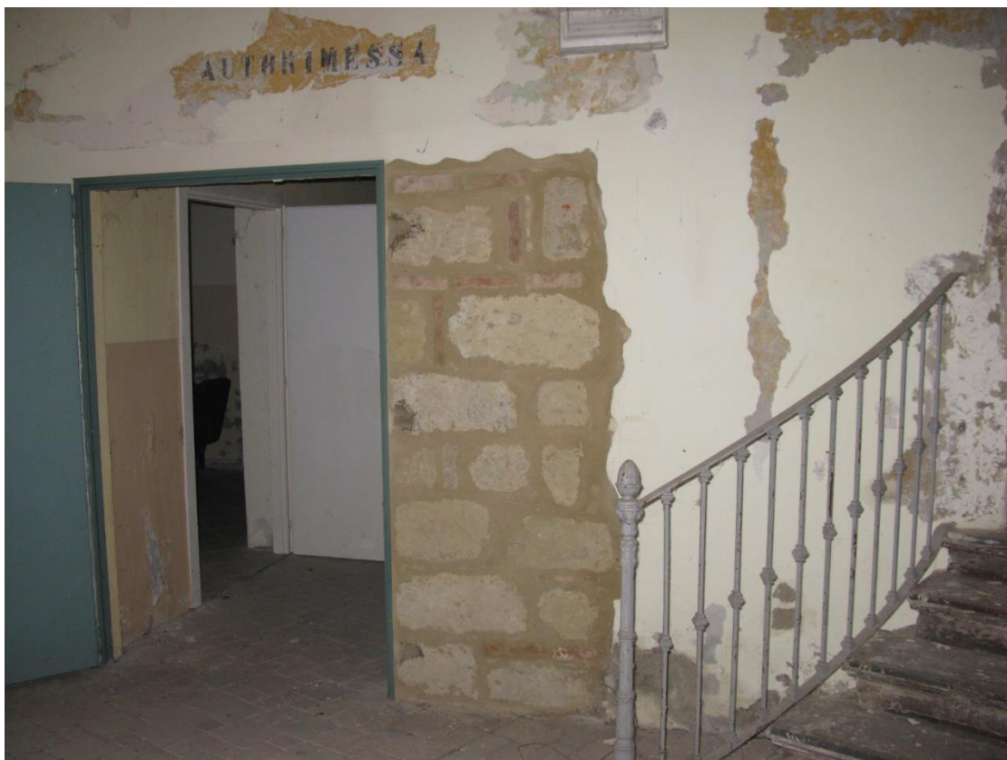
Foto 10 – Ingresso ufficio segreteria piano terreno
