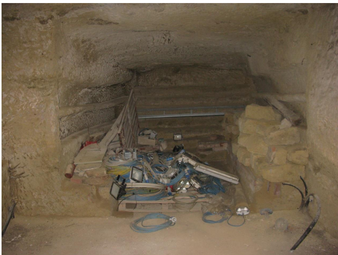
Foto 40 – Infernot locale aula riunione al piano seminterrato, terreno su via G. Garibaldi
