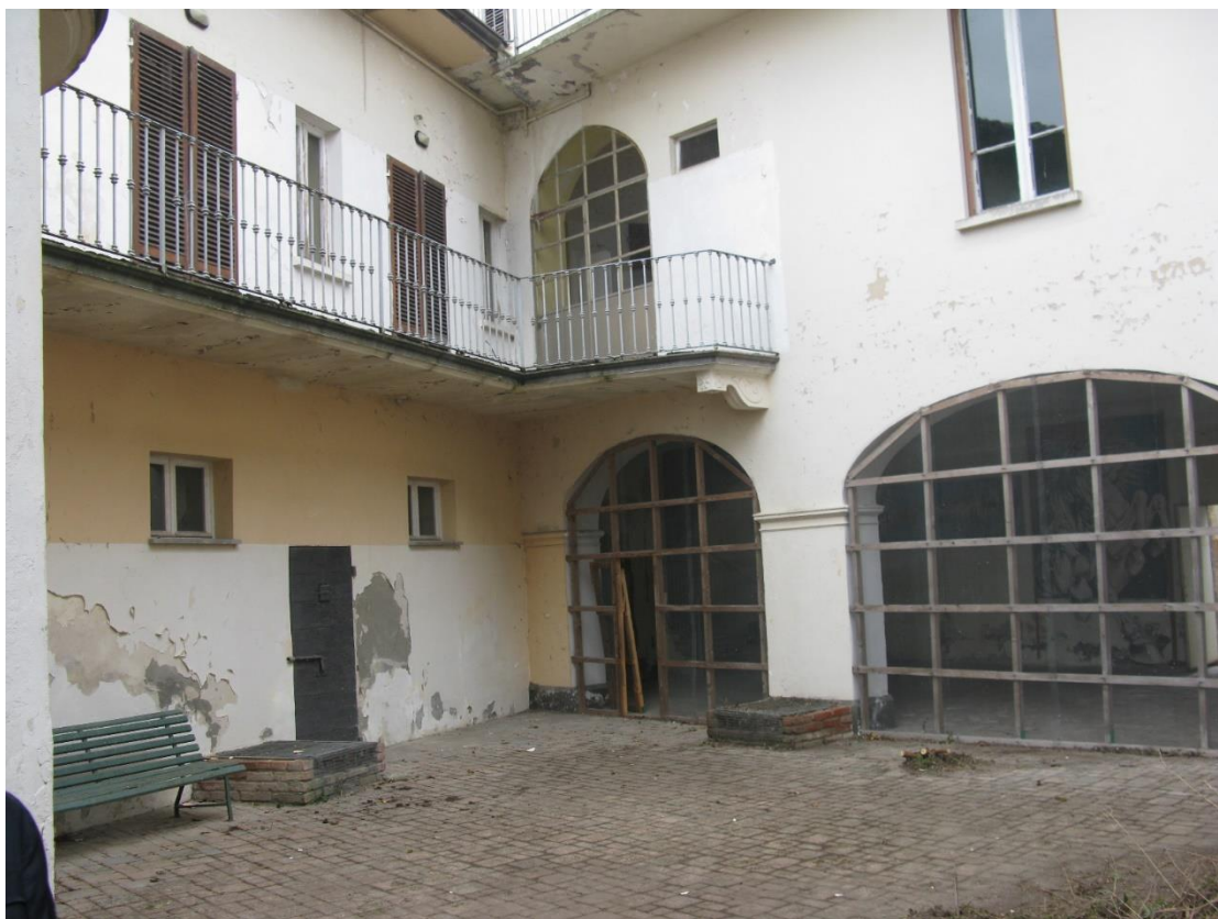
Foto 3 – Facciata ovest interno cortile
