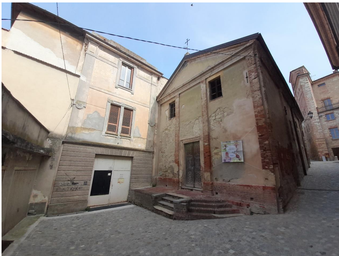
Foto 1 - Ingresso principale da Via Aldo Bergamaschino n.23
