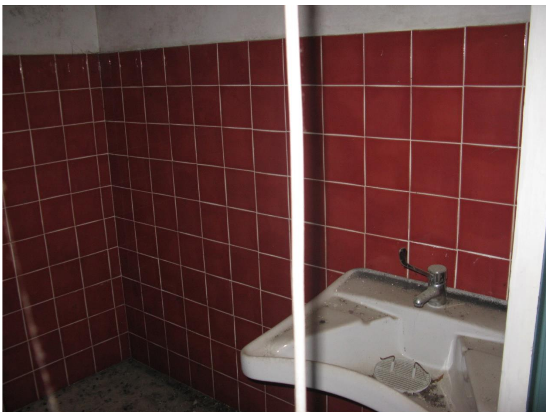
Foto 44 – Bagno disabili al piano seminterrato, terreno su via G. Garibaldi
