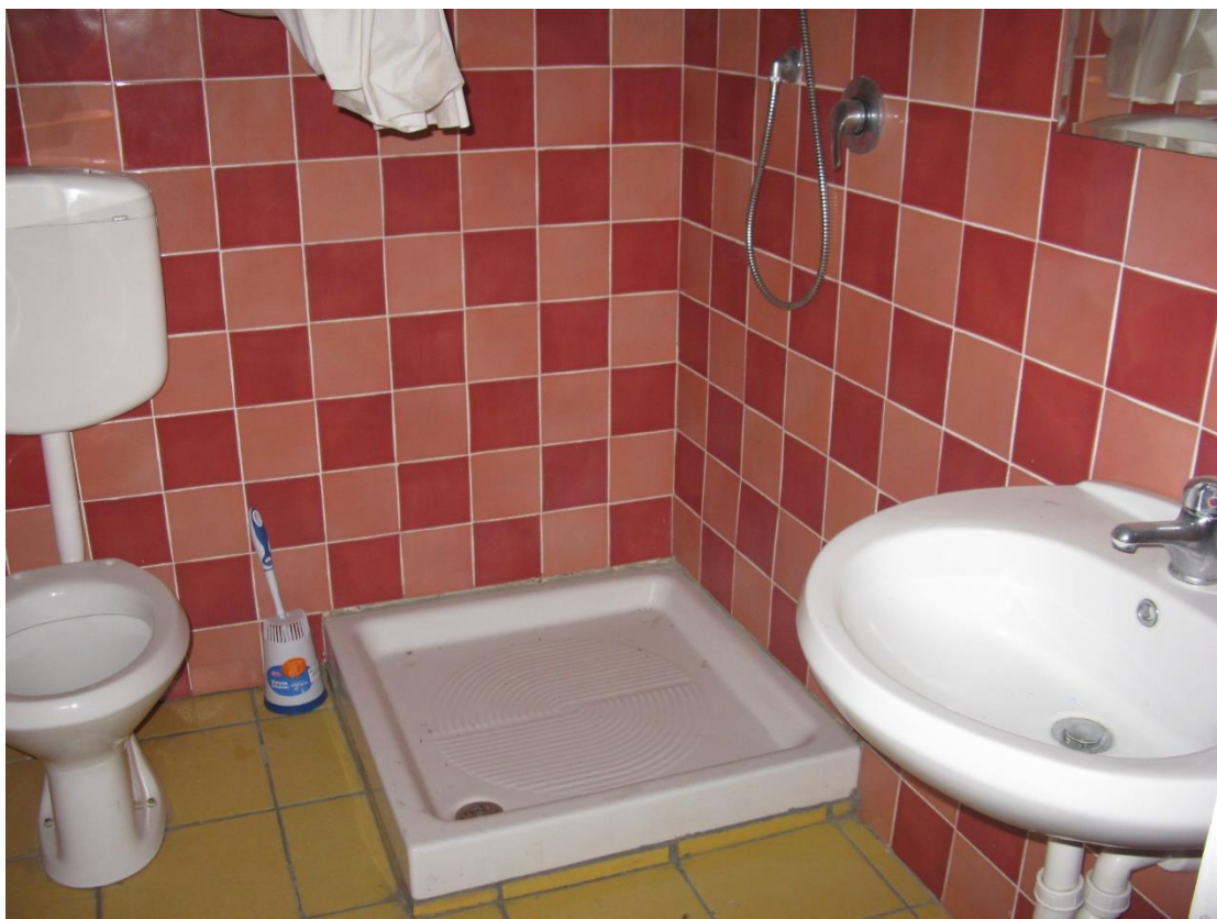
Foto 27 – Bagno seconda camera al piano primo
