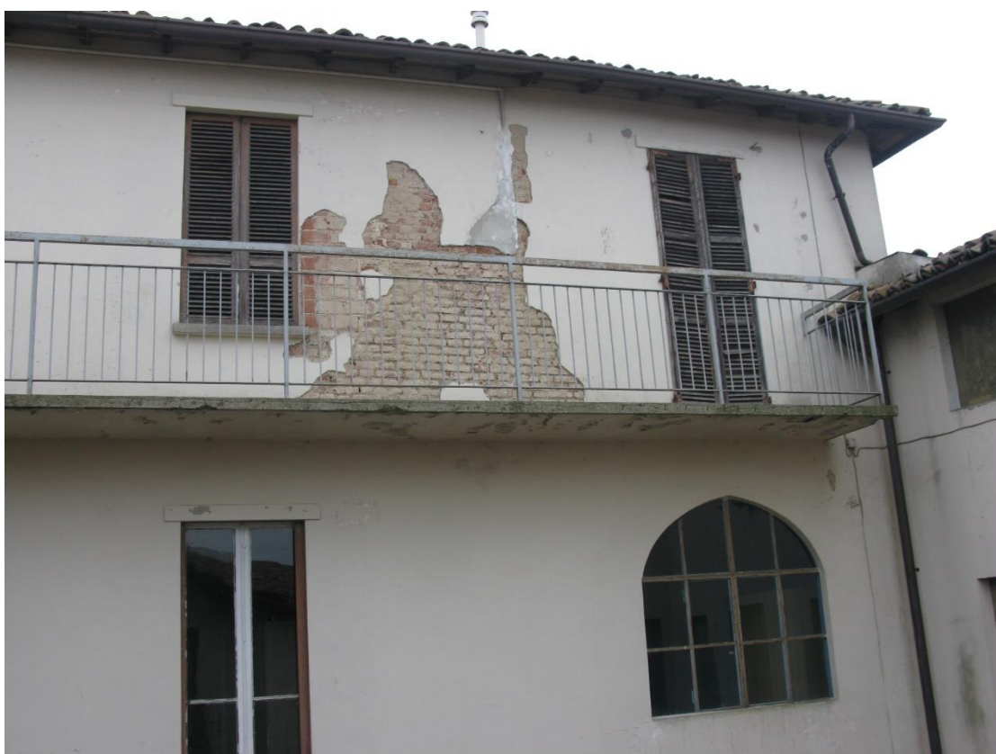
Foto 6 – Facciata ovest interno cortile
