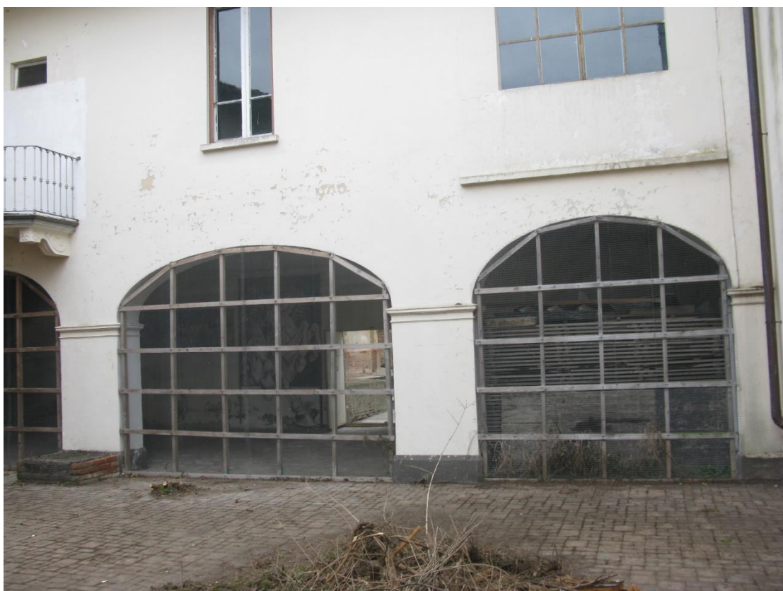
Foto 4 – Facciata ovest interno cortile
