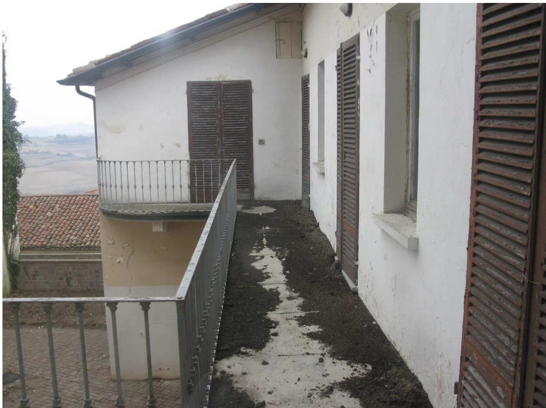
Foto 32 – Balcone piano primo
