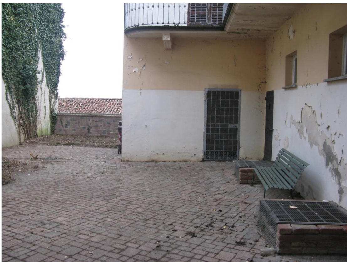
Foto 8 – Facciata sud-est interno cortile
