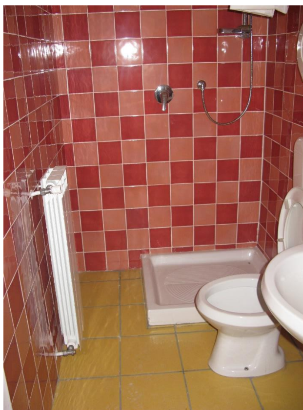
Foto 30 – Bagno terza camera al piano primo
