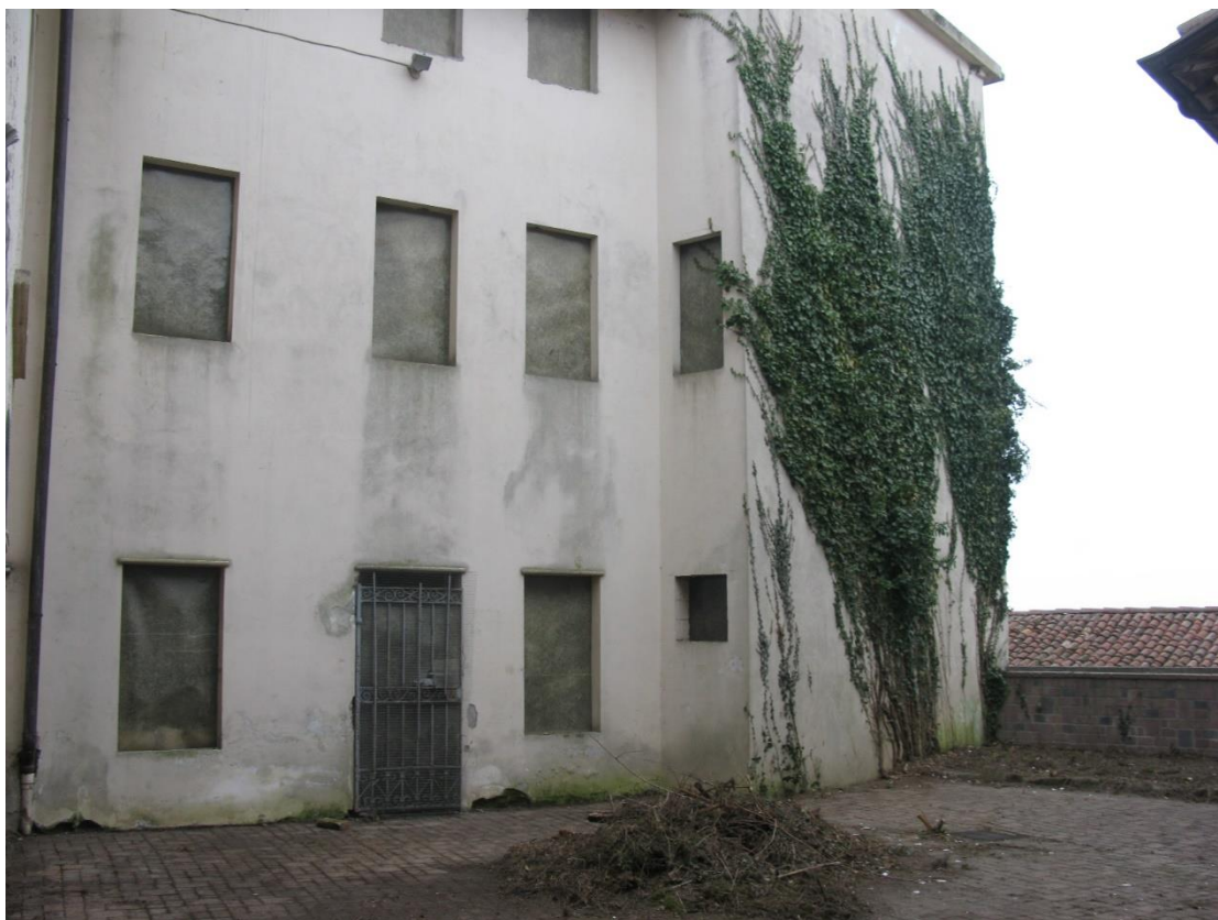
Foto 7 – Facciata nord altra proprietà (particella 578) con diritto di passaggio
