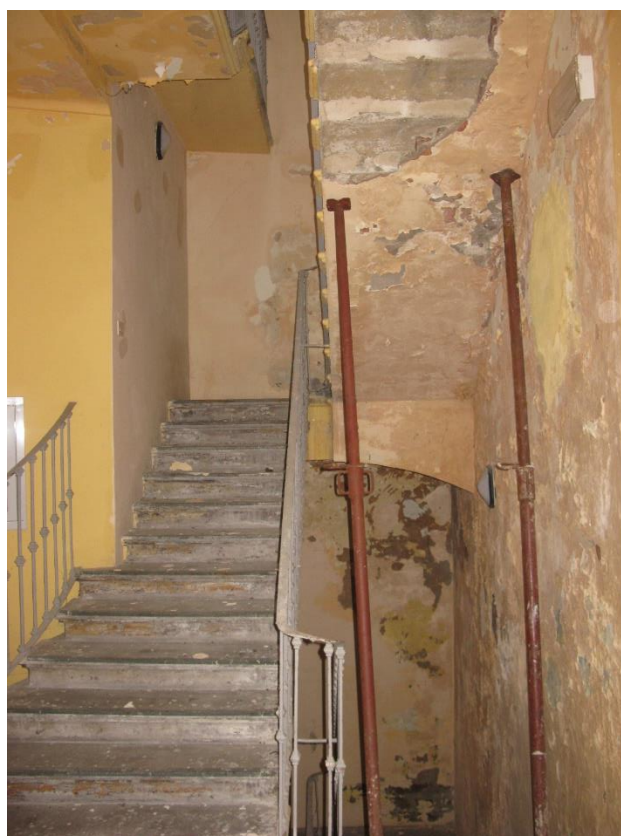
Foto 38 – Scala di accesso al piano secondo
