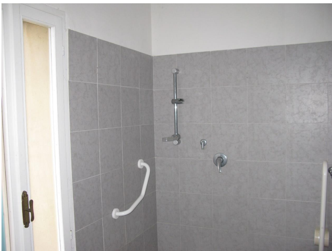
Foto 18 – Bagno disabili al piano terreno
