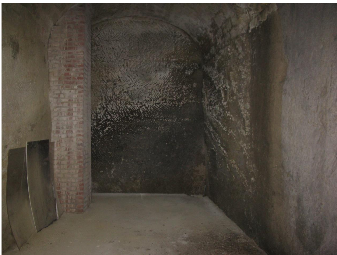
Foto 42 – Locale disimpegno al piano seminterrato, terreno su via G. Garibaldi
