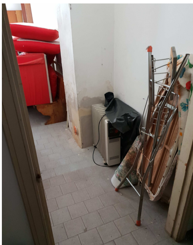
Lavoro realizzato per riparare condotta
