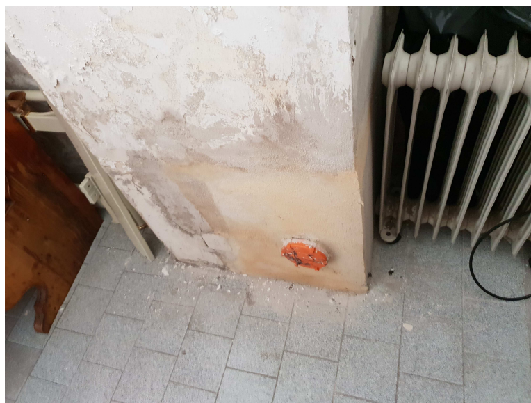
Lavoro realizzato per riparare condotta
