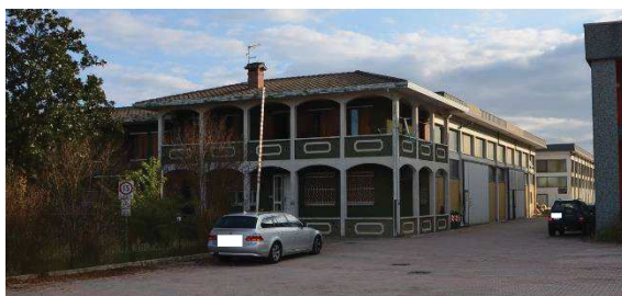
Complesso industriale in via del Santo a San Giorgio delle Pertiche |PD|
