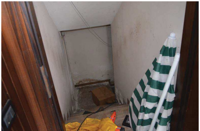
FOTO 33 | Scala di accesso alla cantina
