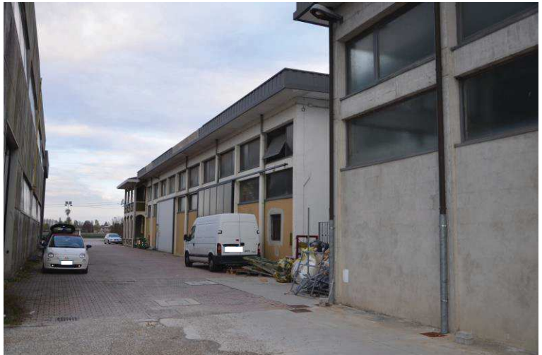
FOTO 2 | Prospetto laterale (sud)
