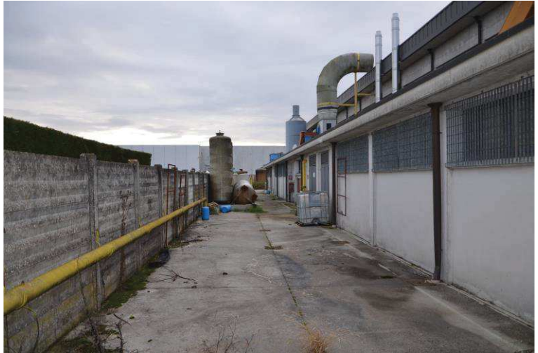
FOTO 19 | Prospetto laterale (nord)
