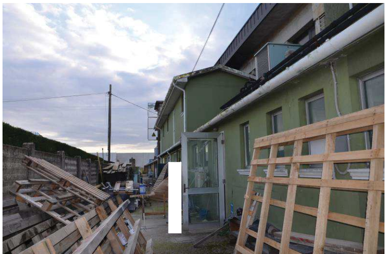
FOTO 3 | Prospetto laterale (nord)
