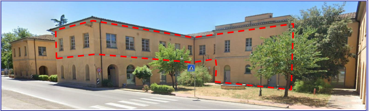
Fig. 1 - Vista da viale Toscana del complesso ex Fattoria Consorzio Tabacchi in cui ricadono alcuni locali oggetto della presente perizia (evidenziati dal contorno rosso).
