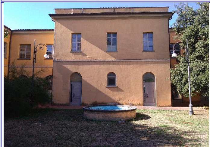
Fig. 4 - L'ingresso da viale Toscana, con il vano scale e locale tecnico al piano terra
