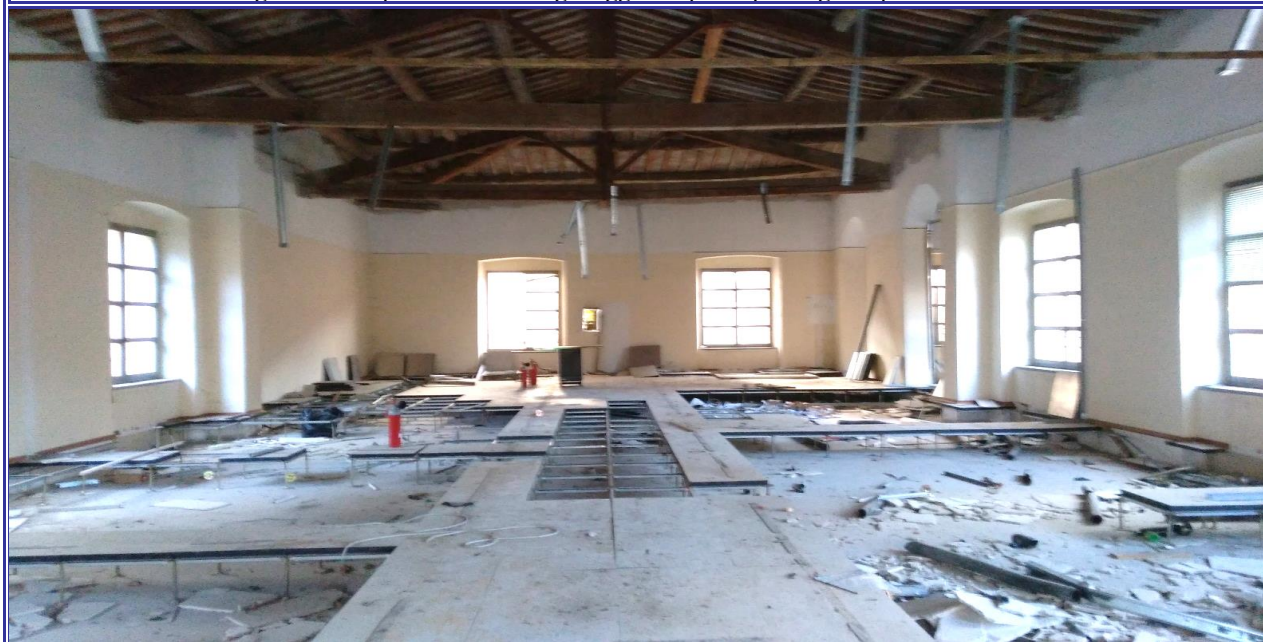
Fig. 10 – La stessa ala vista dalla parte opposta. La struttura è in buone condizioni, mancano gli impianti e la pavimentazione
