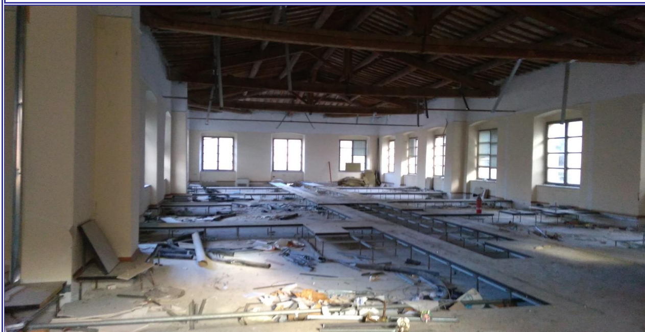
Fig. 9 – Altra ala dell'edificio fino a pochi anni fa articolata da divisori di cartongesso in uffici, controsoffitti pure in cartongesso e con pavimentazione galleggiante per ospitare gli impianti termofluidici.
