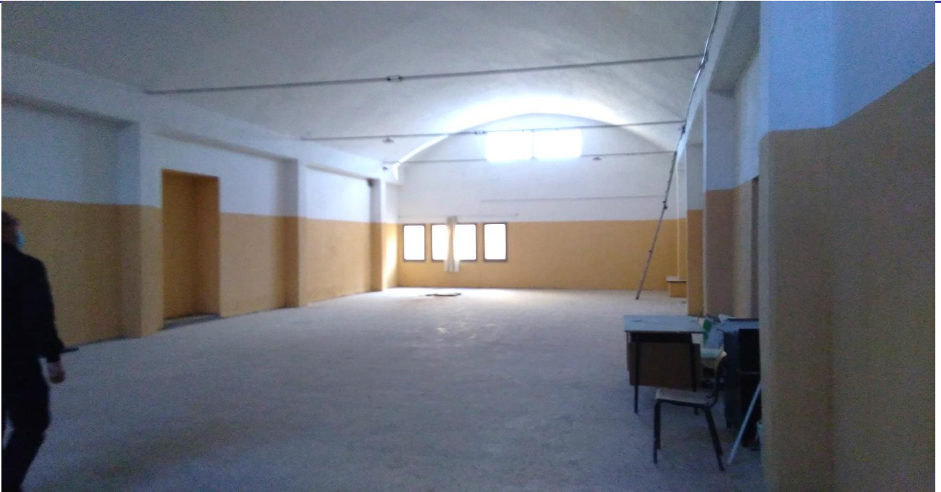
Fig. 15 – Altro ampio salone al piano primo. Tale locale è identificato con il sub 62 e parte del 61.
