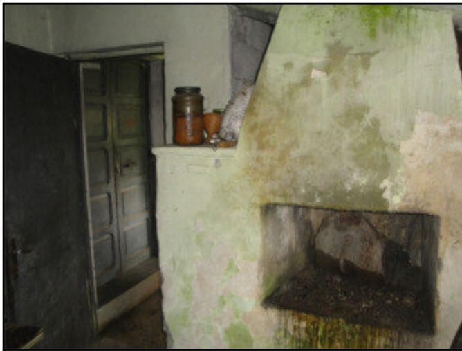
FOTO N. 9 RIPOSTIGLIO - FORNO - LEGNAIA
