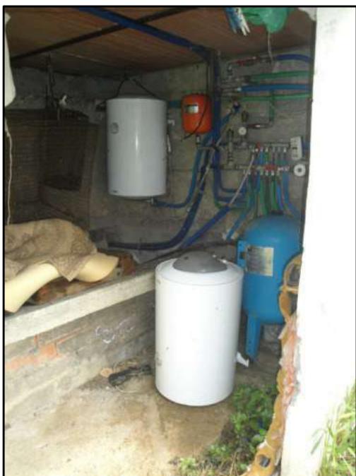
FOTO P LOCALE TECNICO
