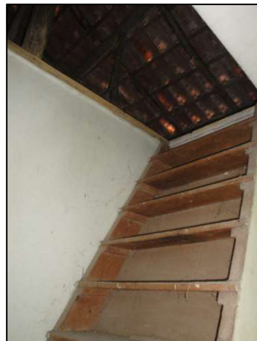
FOTO N. 4 SCALA ACC. SOTTOTETTO
