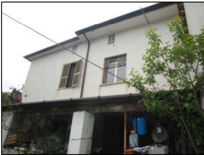
FOTO N. 6 bis PROSPETTO SUD-OVEST
