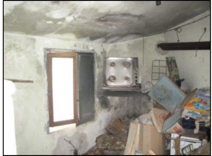
FOTO N. 8 RIPOSTIGLIO - FORNO - LEGNAIA
