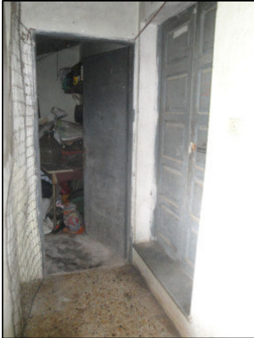
FOTO N. 7 INGRES. RETRO ZONA "B" INGRESSO RIPOSTIGLIO - FORNO
