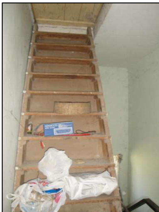
FOTO N. 3 SCALA ACC. SOTTOTETTO
