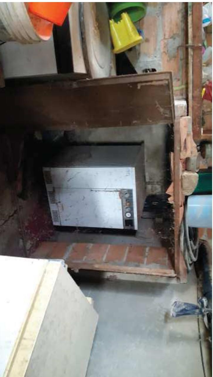
interno abitazione piano seminterrato
