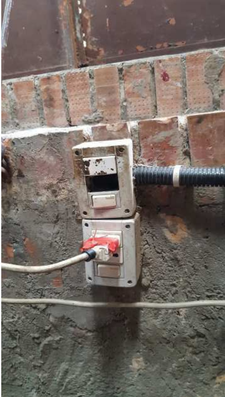
interno abitazione piano seminterrato
