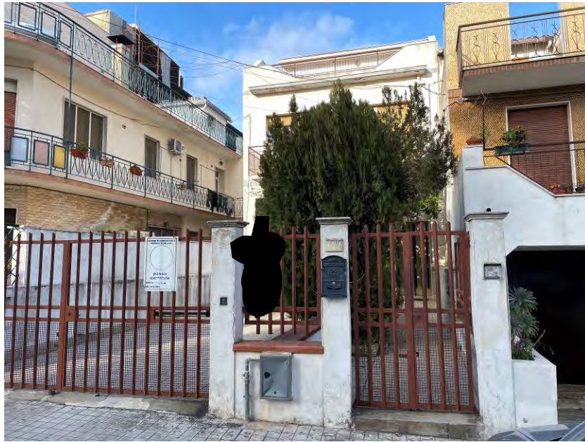
FOTO 1 – prospetto su Via Vittorio Emanuele III
