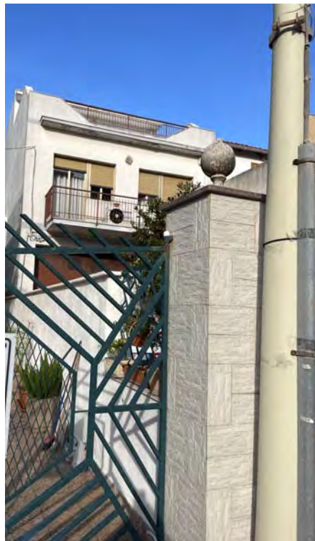
FOTO 2 – prospetto su Via Vittorio Emanuele III
