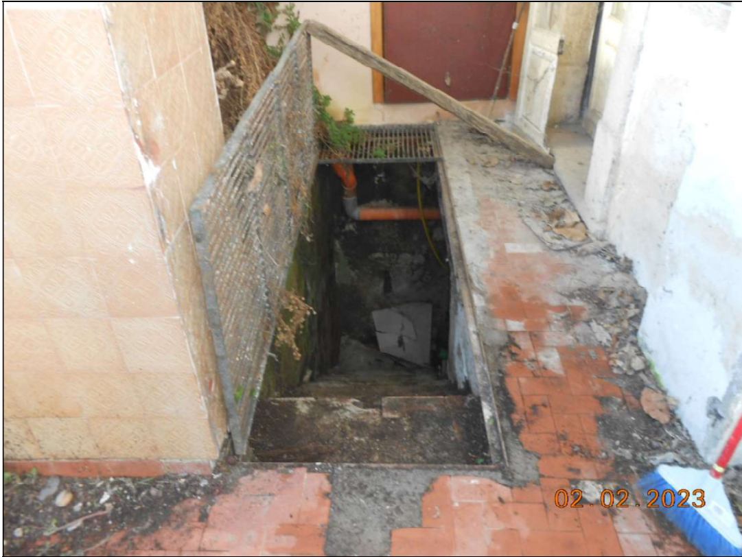
FOTO N. 07 Vista scala esterna di accesso al piano interrato.
