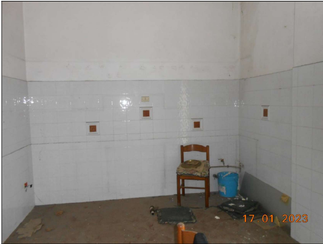
FOTO N. 47 Vista interna del piano primo.
