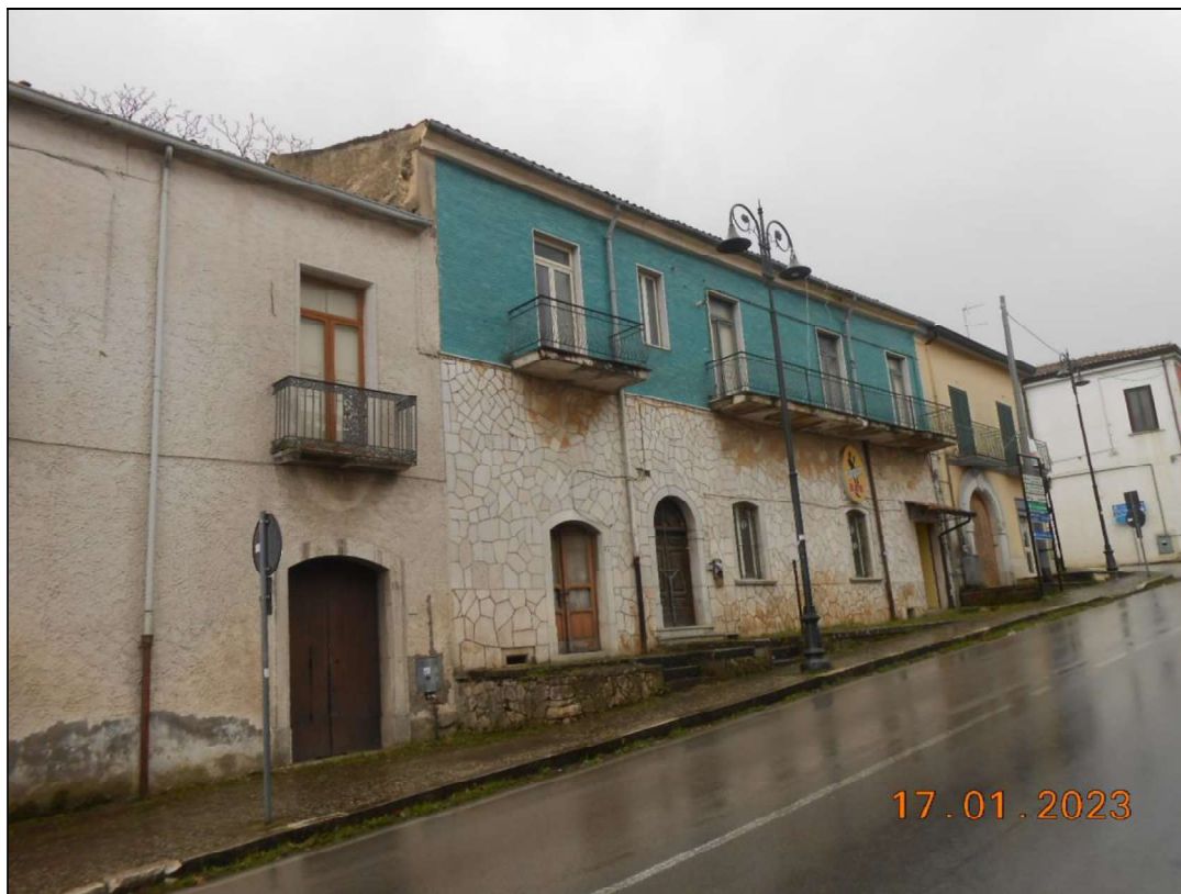
FOTO N. 01 Vista dell'immobile pignorato, ricadente in un fabbricato in linea.
