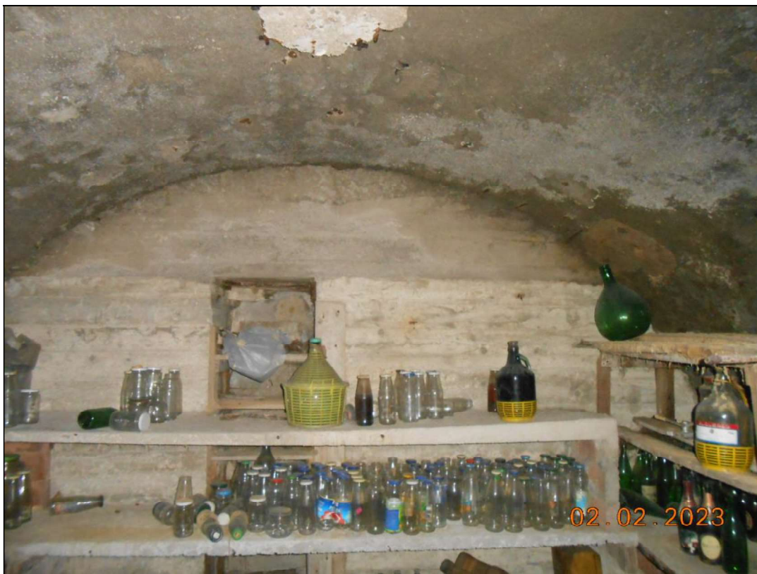
FOTO N. 11 Vista interna del piano interrato dell'immobile pignorato.
