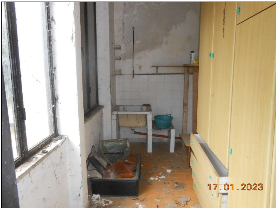
FOTO N. 56 Vista della lavanderia al piano primo.
