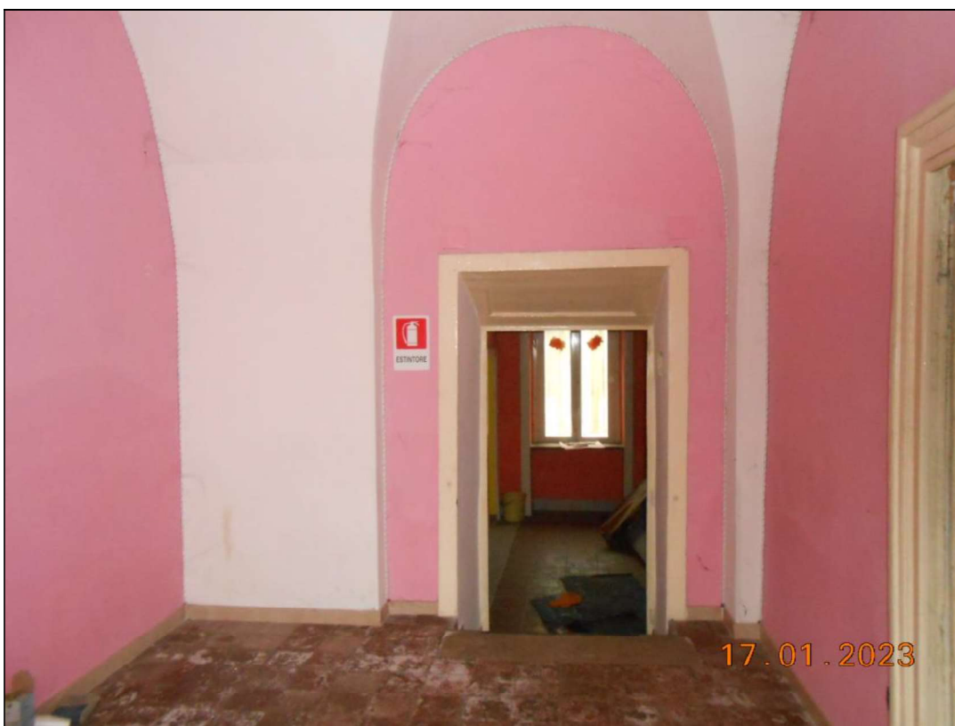
FOTO N. 26 Vista interna del piano terra.
