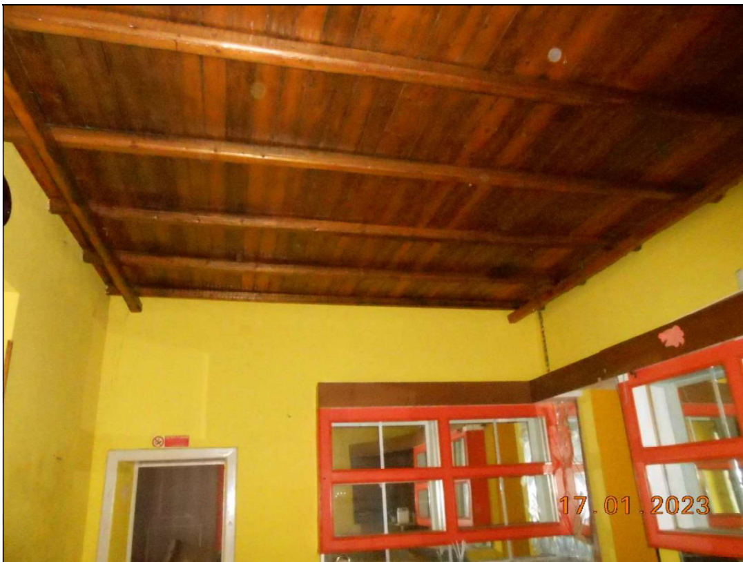
FOTO N. 20 Vista interna del piano terra, prima adibita a bar.
