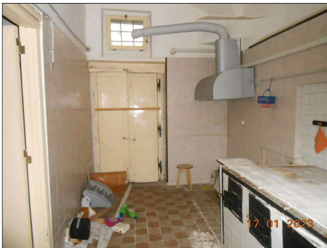
FOTO N. 28 Vista interna del piano terra.
