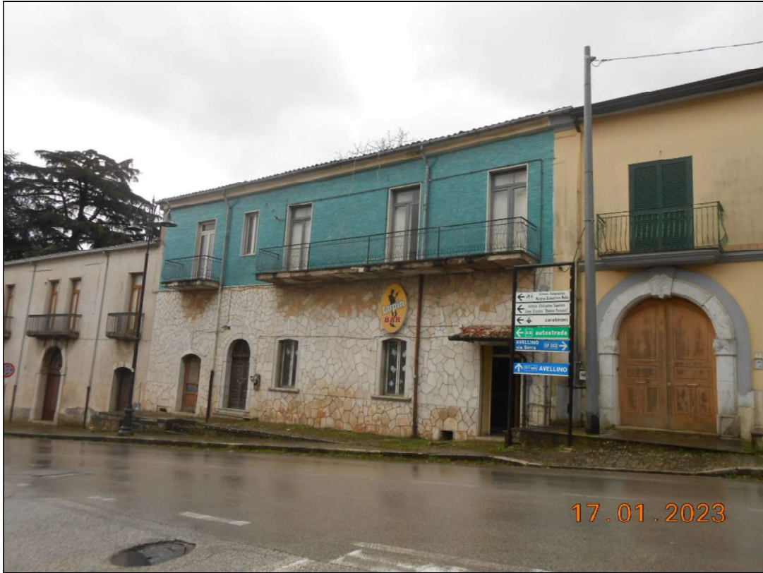
FOTO N. 05 Vista dell'immobile pignorato.
