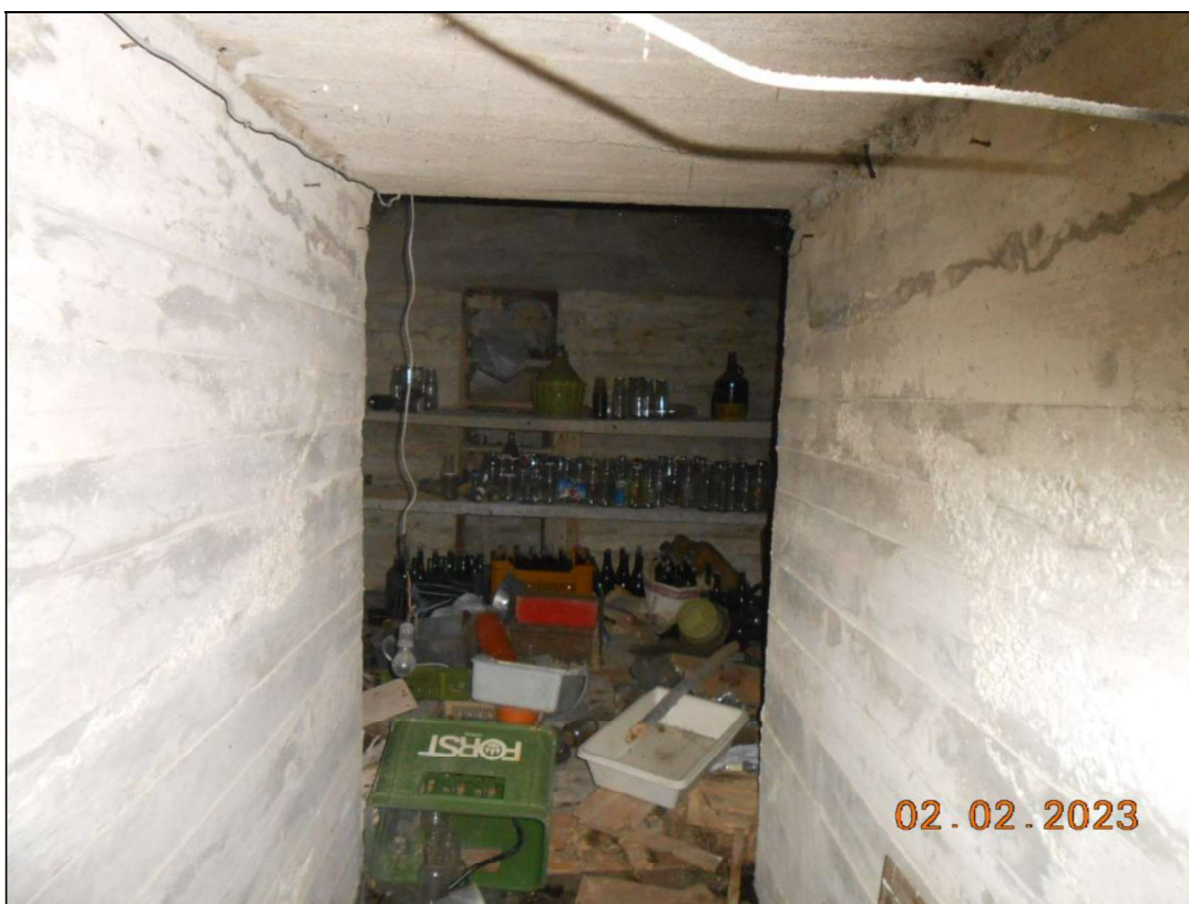
FOTO N. 10 Vista interna del piano interrato dell'immobile pignorato.
