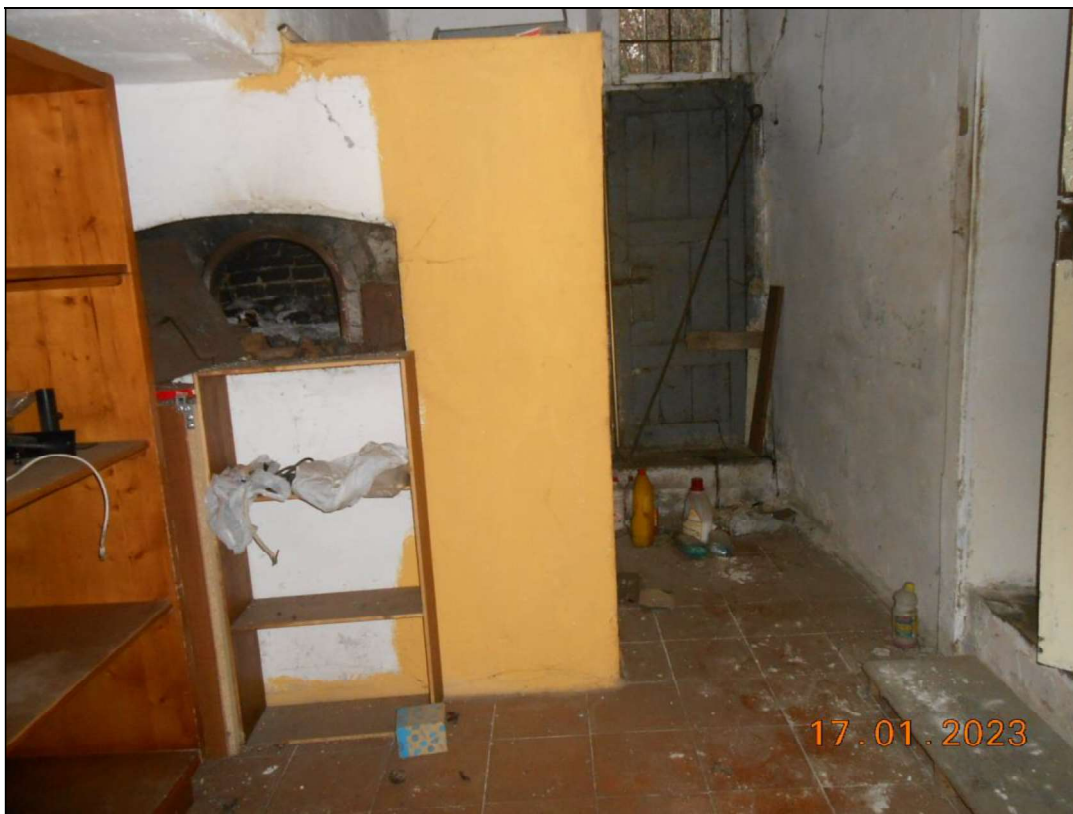
FOTO N. 31 Vista interna del piano terra.
