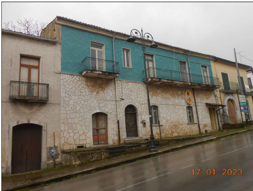
FOTO N. 03 Vista dell'immobile pignorato, a confine con via Roma.
