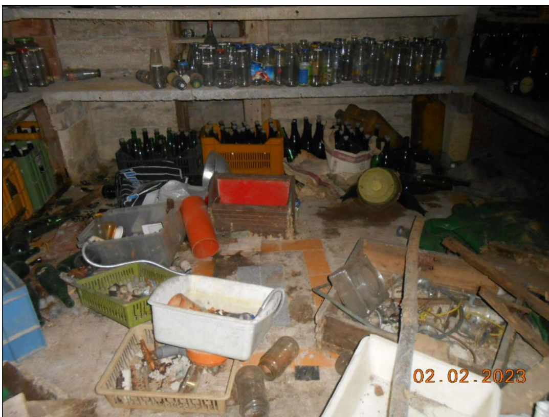
FOTO N. 12 Vista interna del piano interrato dell'immobile pignorato. Si notano rifiuti di ogni genere.
