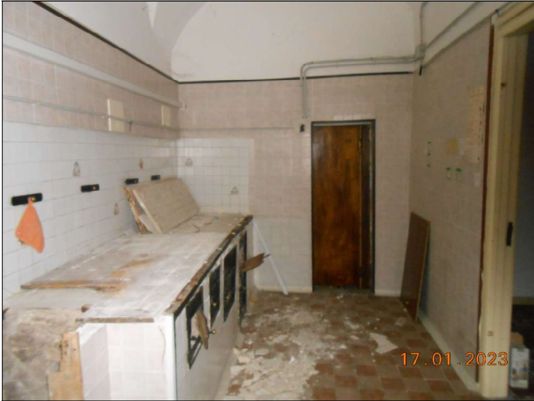
FOTO N. 29 Vista interna del piano terra.
