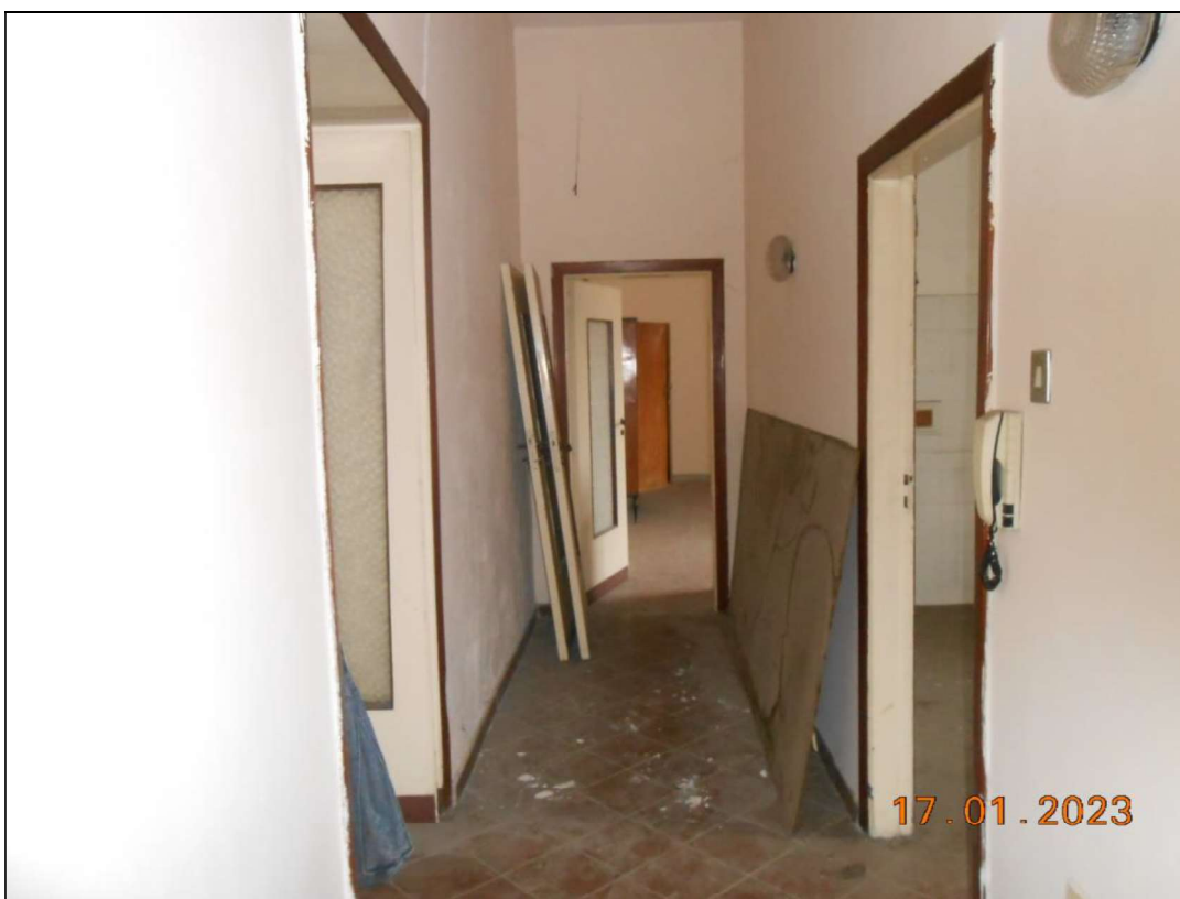
FOTO N. 46 Vista interna del piano primo.
