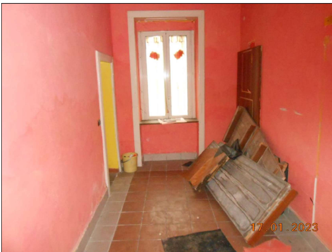
FOTO N. 22 Vista interna del piano terra.
