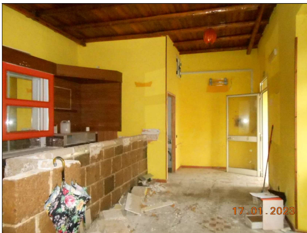
FOTO N. 18 Vista interna del piano terra dell'immobile pignorato. Si nota la parte che era adibita a bar.
