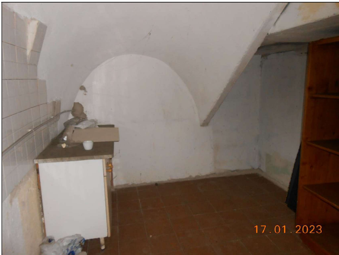
FOTO N. 30 Vista interna del piano terra.
