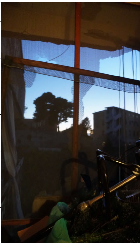
Foto n.12: immagine della veranda.
