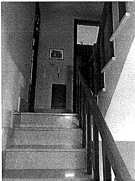
Scala di collegamento interna tra il piano primo e secondo
