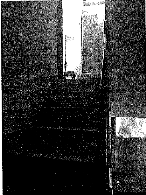
Scala di collegamento interna tra il piano secondo e terzo
