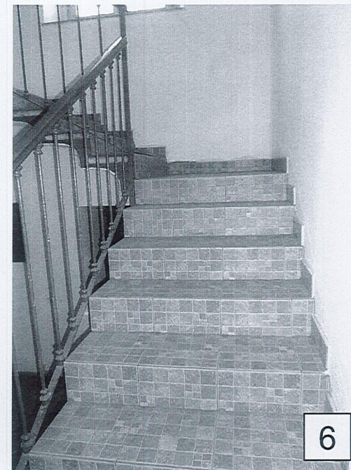
Vano scala comune
