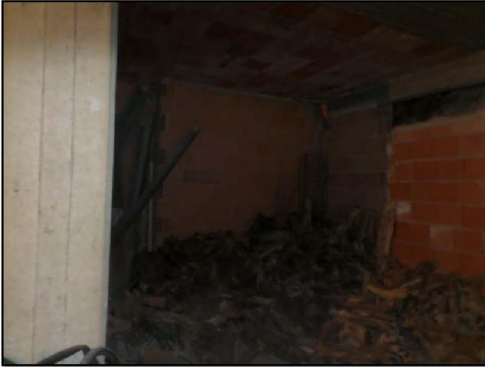
Vista interna del locale sub 2
