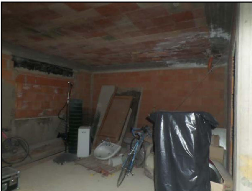
Vista interna del locale sub 2
