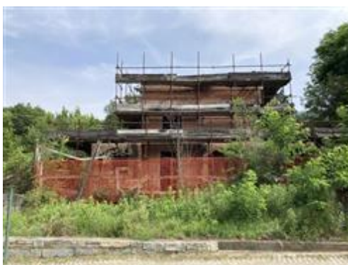
Vista generale del cantiere dalla strada interna di Via Moncurto
