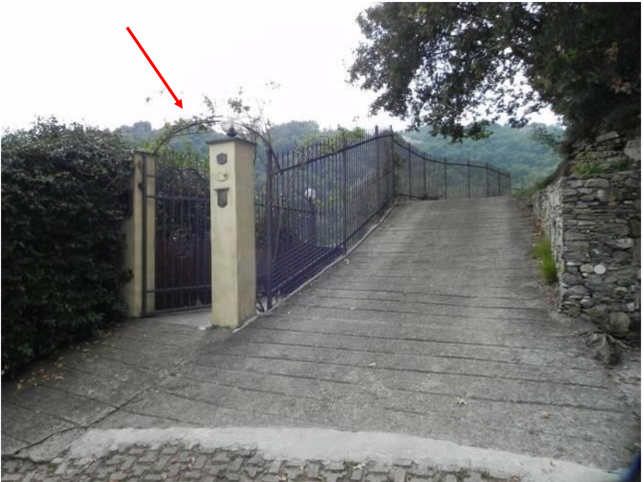
Foto da 52 a 54 – Viste della strada vicinale che dà accesso alla proprietà In evidenza il cancello che dà accesso all'appartamento oggetto di perizia
