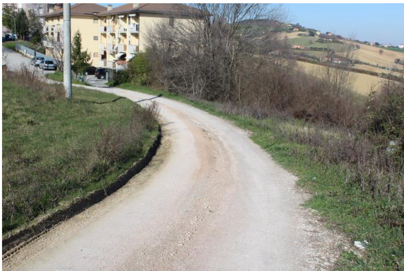
FOTO 16 – PARTICOLARE STRADA CHE ATTRAVERSA IL TERRENO, PREVISTA DA SPOSTARE NEL VIGENTE P.R.G.
