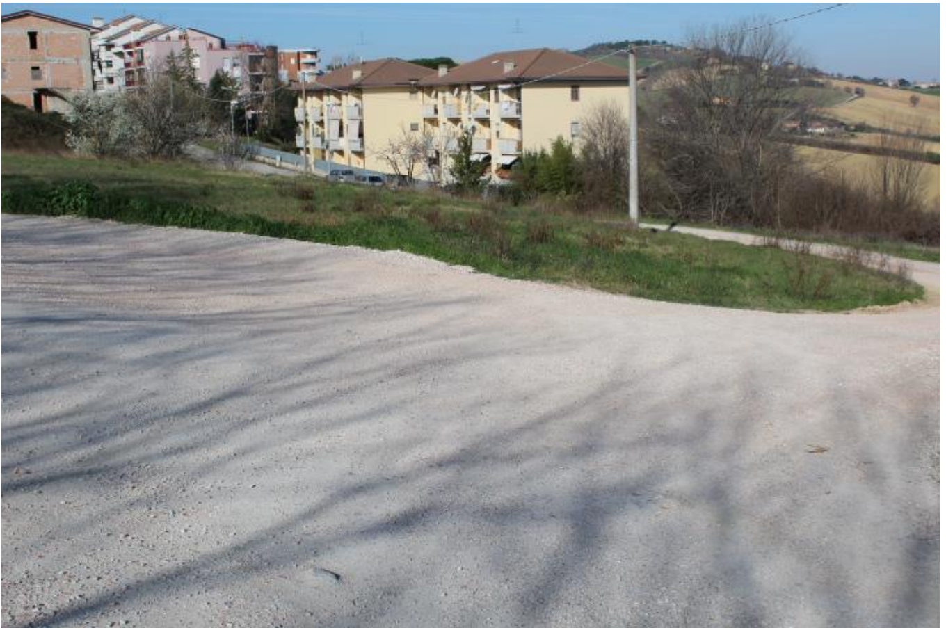
FOTO 11 – VISTA DEL TERRENO DA EST VERSO OVEST E STRADA DA SPOSTARE
