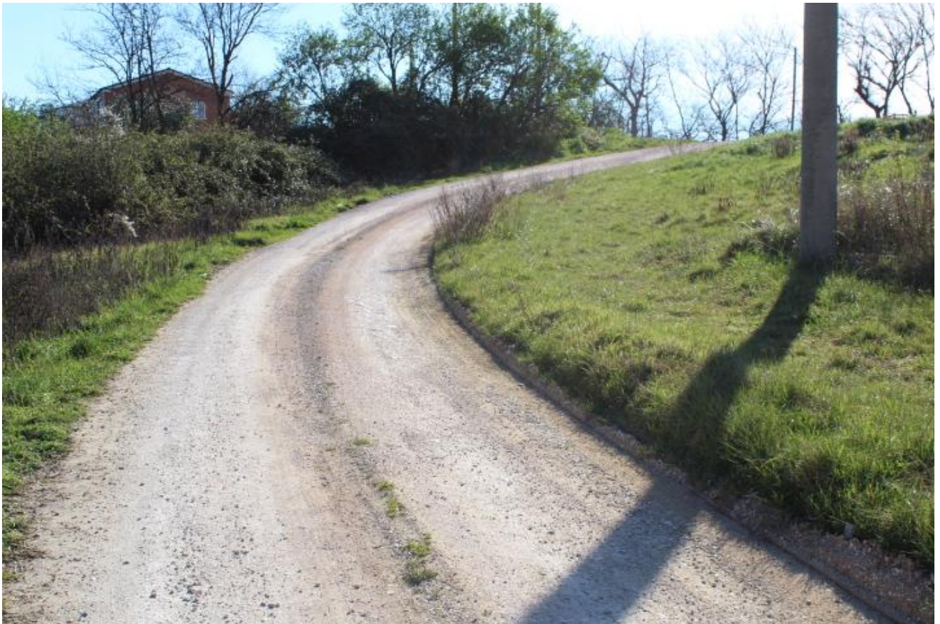
FOTO 23 – VISTA STRADA VERSO SUD-EST
