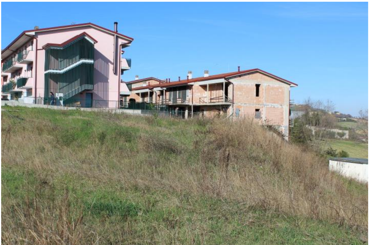
FOTO 4 – INTORNO DEL TERRENO
