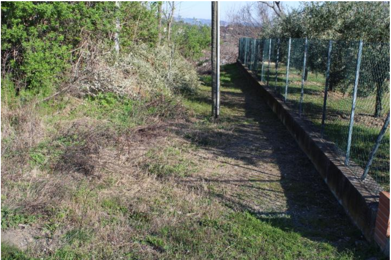
FOTO 9 – PARTICOLARE DELLA RECINZIONE LATO EST ESISTENTE con un palo della linea elettrica
