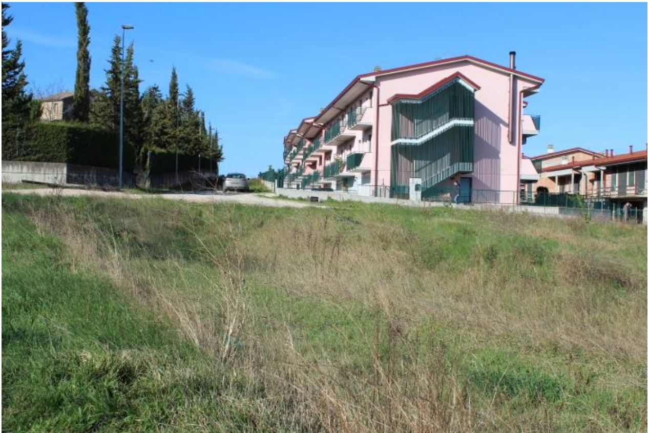
FOTO 3 – INTORNO DEL TERRENO
