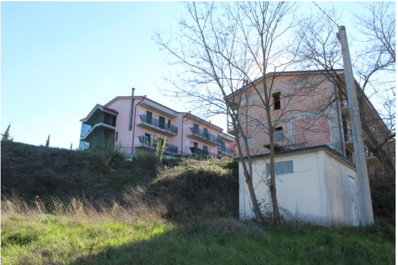
FOTO 13 – PARTICOLARE DELLA CABINA ELETTRICA (posta ad ovest rispetto al terreno), DA CUI PARTE LA LINEA CHE ATTRAVERSA IL TERRENO
