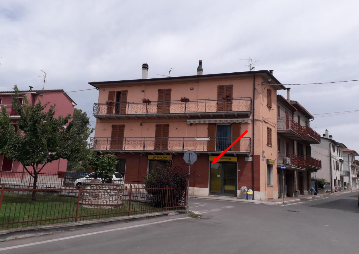
Foto n. 2: vista esterno palazzina, Selci Lama-San Giustino, foglio 72, part. 84 lati sud-ovest
