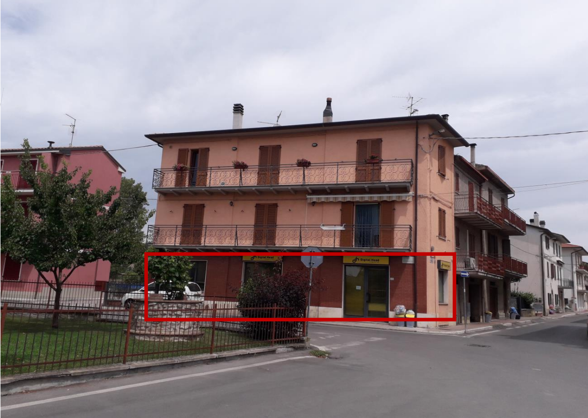
Foto n. 1: vista esterno palazzina, Selci Lama-San Giustino, foglio 72, part. 84 lati sud-est
