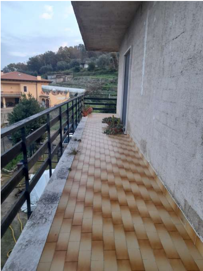
foto 19 balcone soggiorno cucina piano primo
