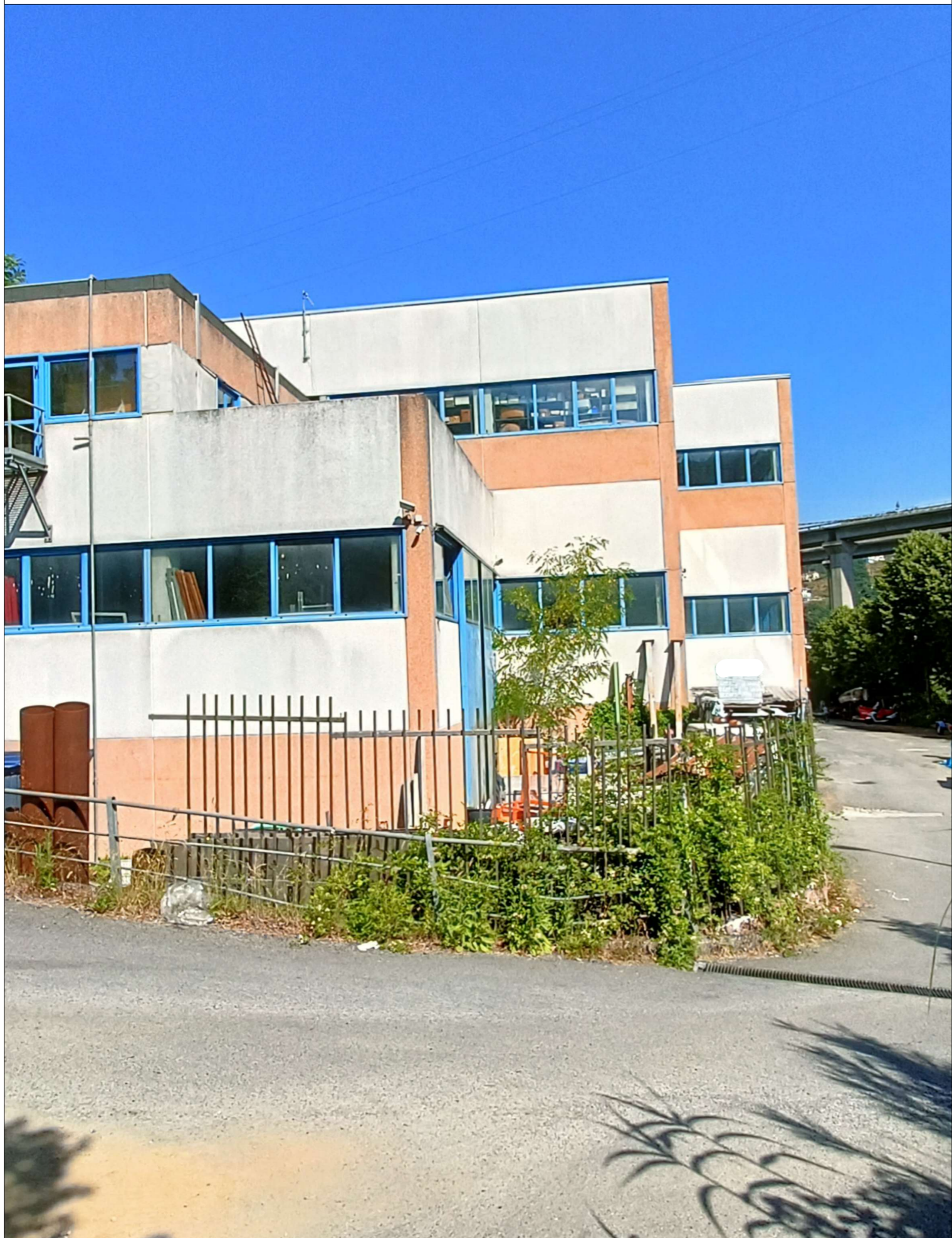
Foto n.2: particolare del prospetto
