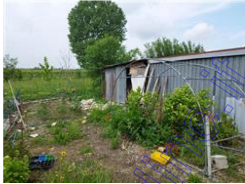
porzione ampliamento non autorizzato
