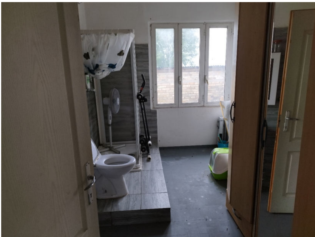
Particolare bagno P1° (ex camera da letto)
