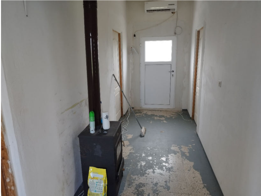
Particolare corridoio P1°
