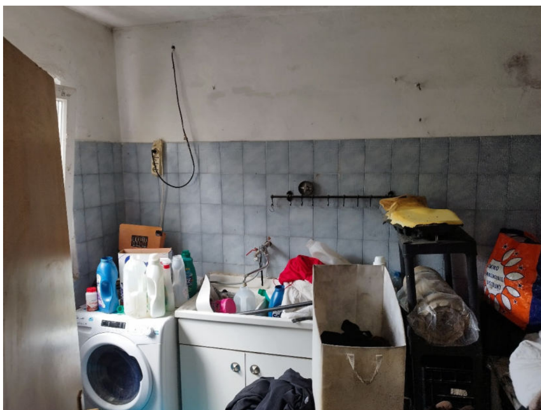
Particolare lavanderia PT (ex cucina)
