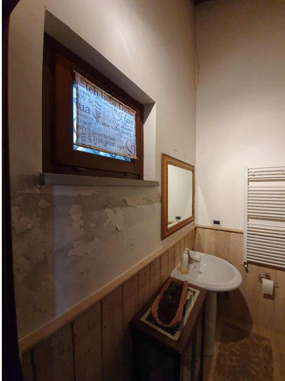
Foto 5- Bagno piano terra
