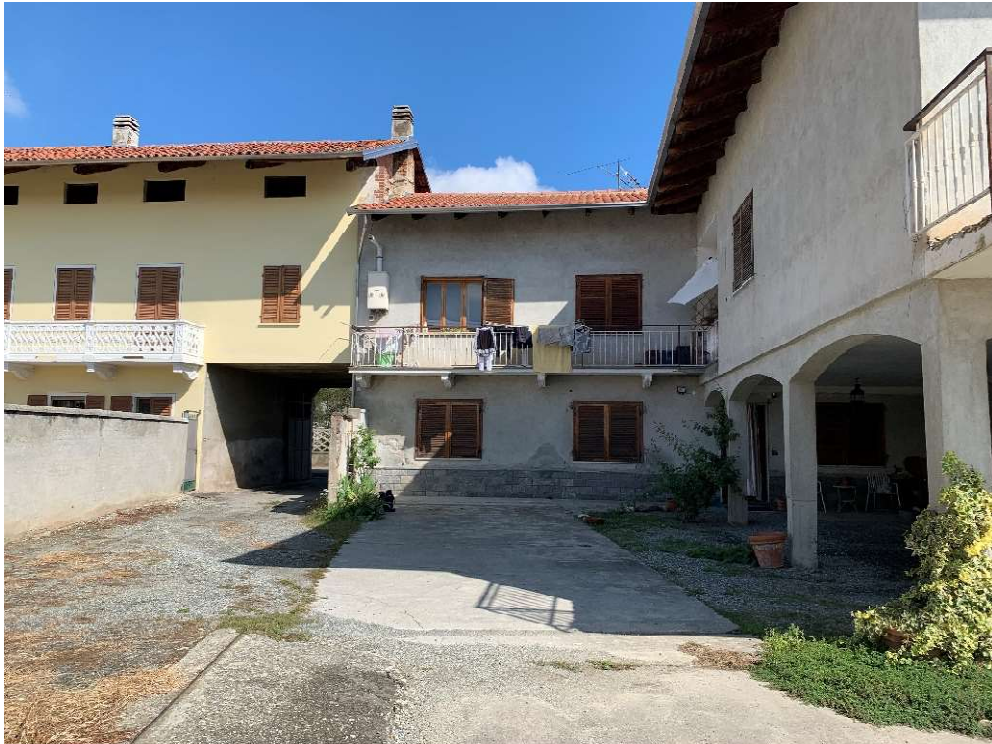
Foto 2 – Vista generale dell'abitazione dal cortile
