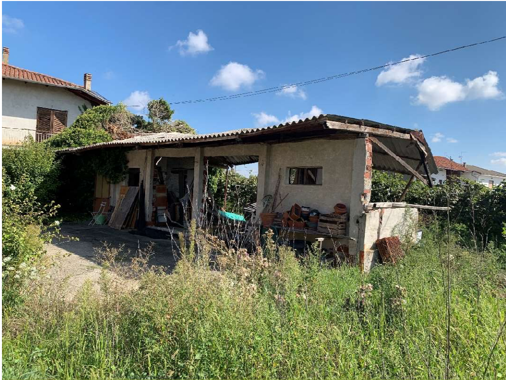
Foto 3 – Vista generale della tettoia isolata
