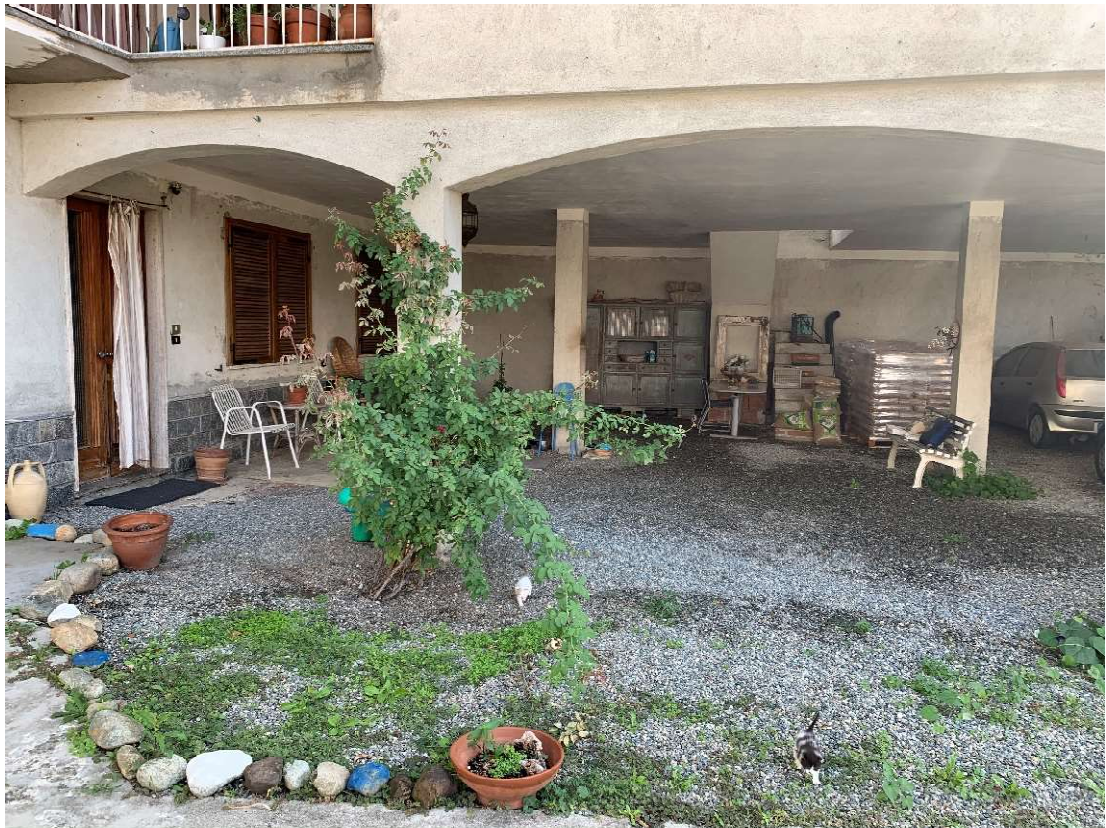
Foto 11 – Porticato sotto appartamento zona cortile
