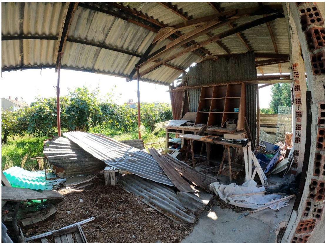
Foto 6 – Interno della tettoia
