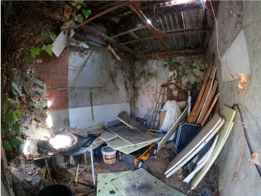
Foto 5 – Interno del deposito della tettoia isolata
