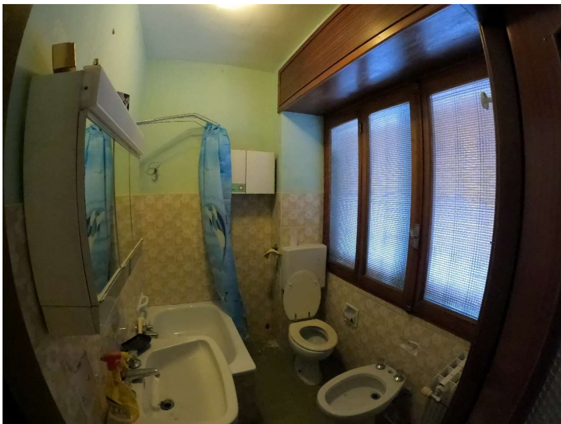
Foto 21 – Bagno appartamento piano terreno lato strada
