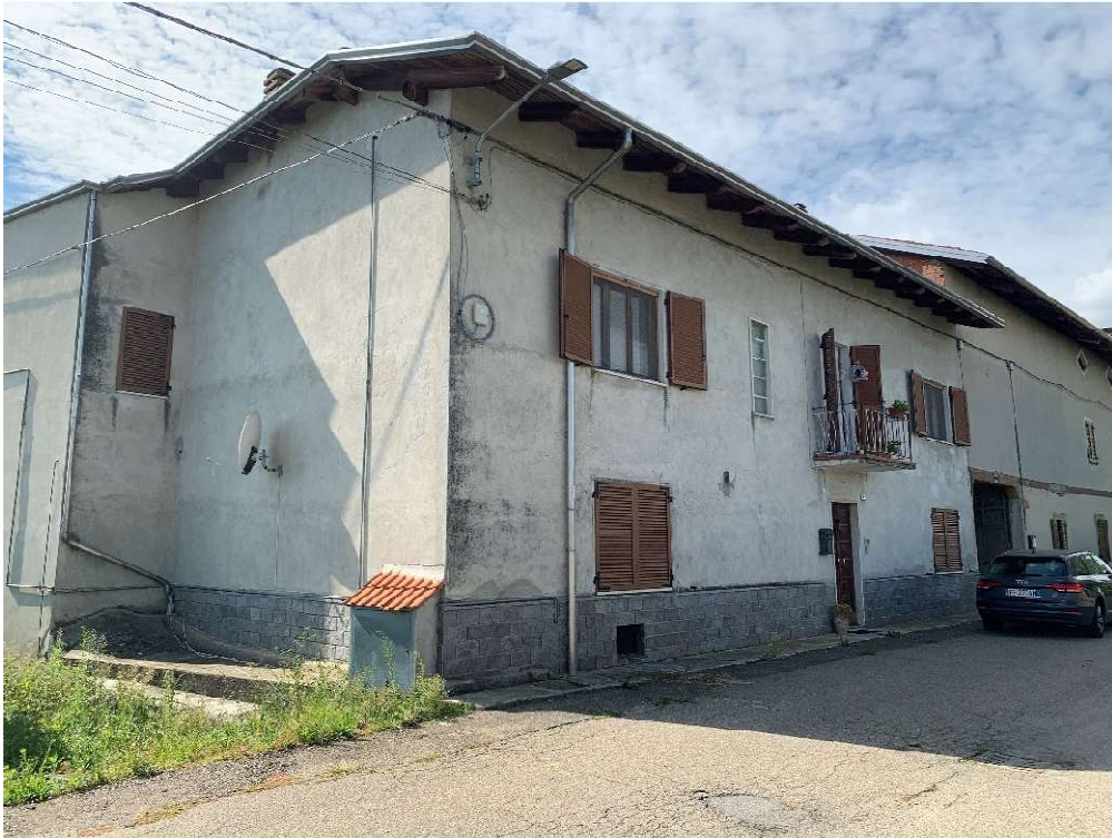
Foto 1 – Vista generale dell'abitazione dalla strada
