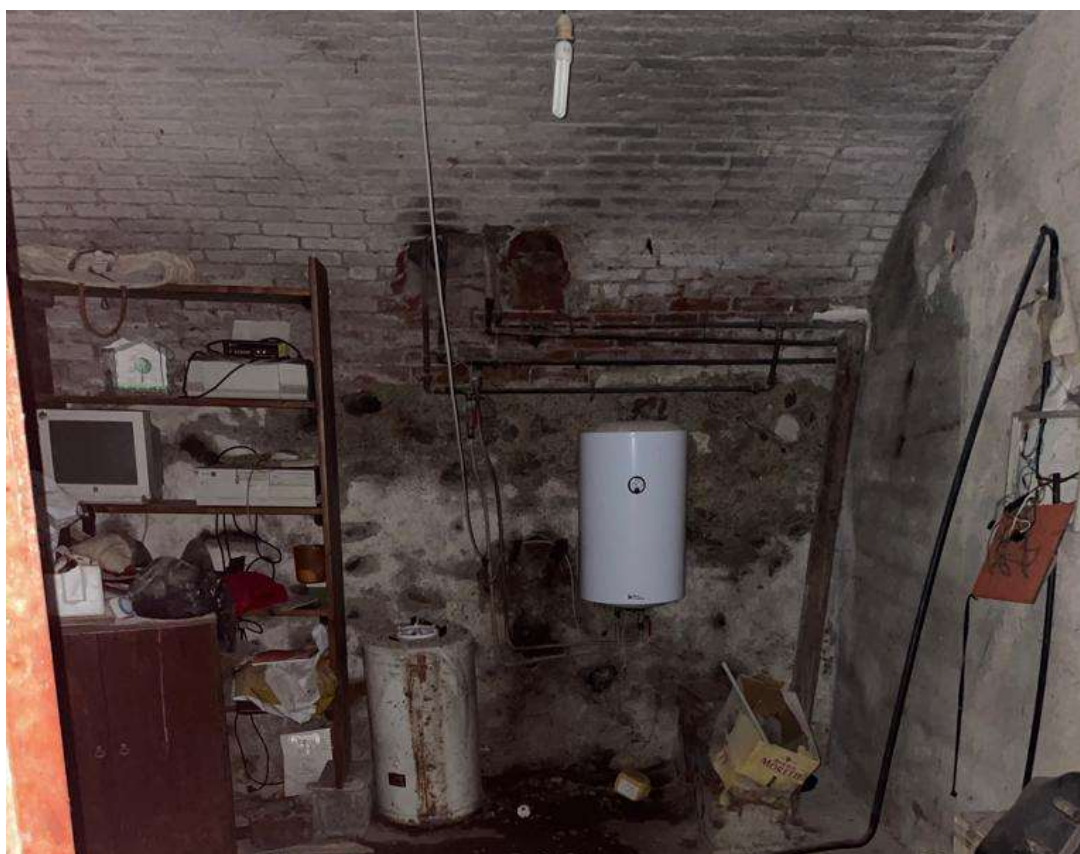
Foto 22 – Cantina piano interrato lato strada
