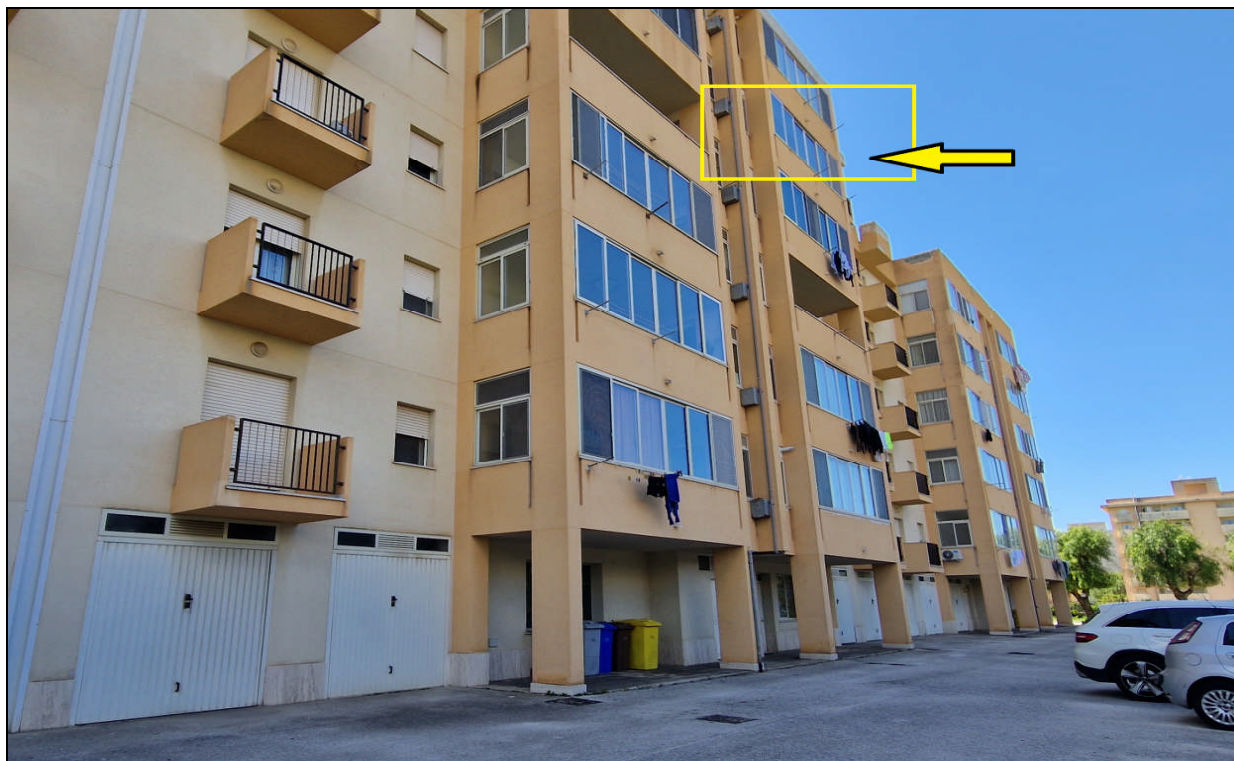
Foto 3: Panoramica esterna lato posteriore – edificio “B” ubicazione appartamento piano 5°.
