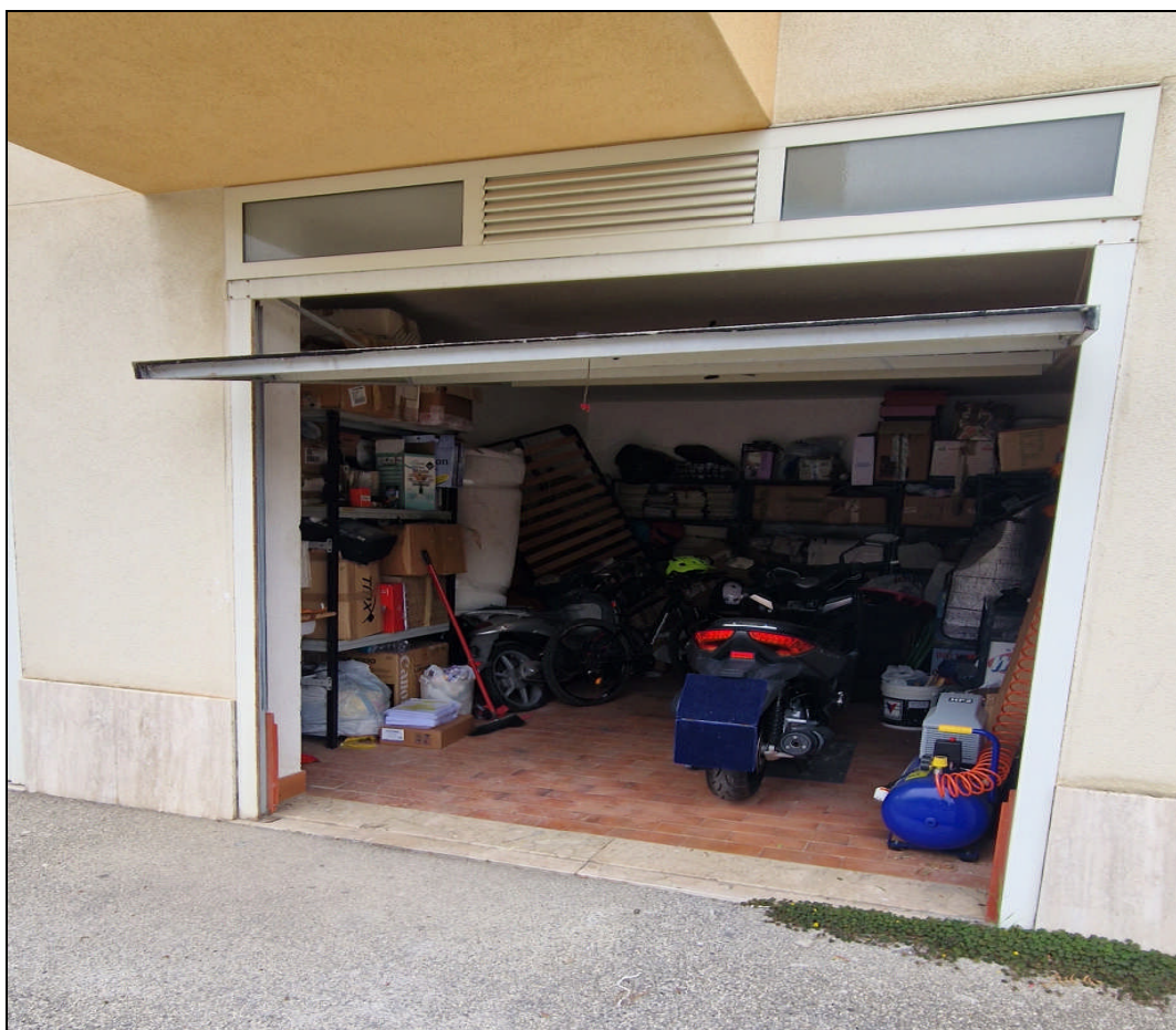
Foto 13: Particolare ingresso locale garage.
