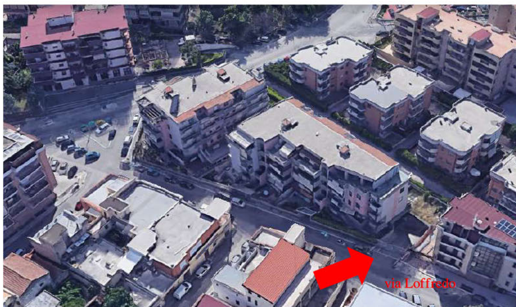
Vista del fabbricato ove ubicato l'immobile ad uso box
