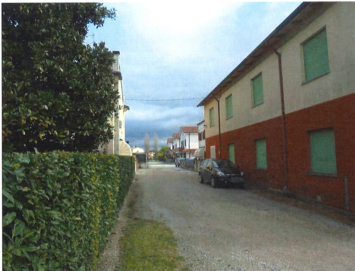
Foto 4. Prospetto Nord – Ovest. Vista da Via Provinciale.
