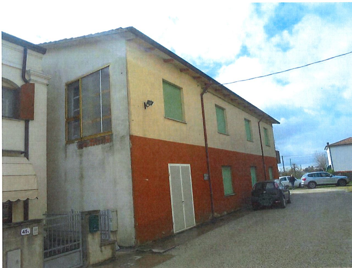
Foto 5. Prospetto Nord – Ovest. Vista da passo carrabile..
