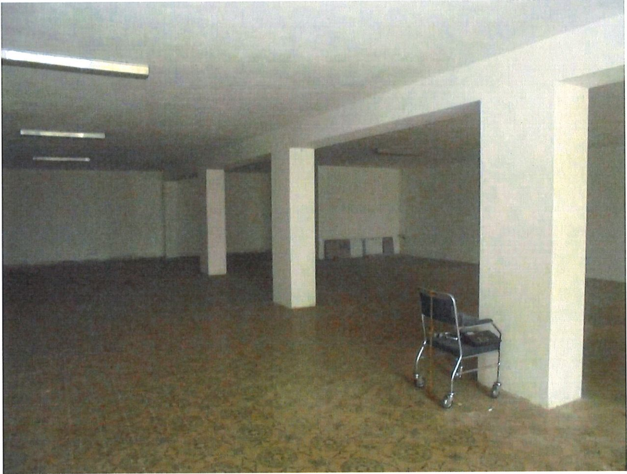
Foto 13. Magazzino – Piano terra. Particolare degli interni.
