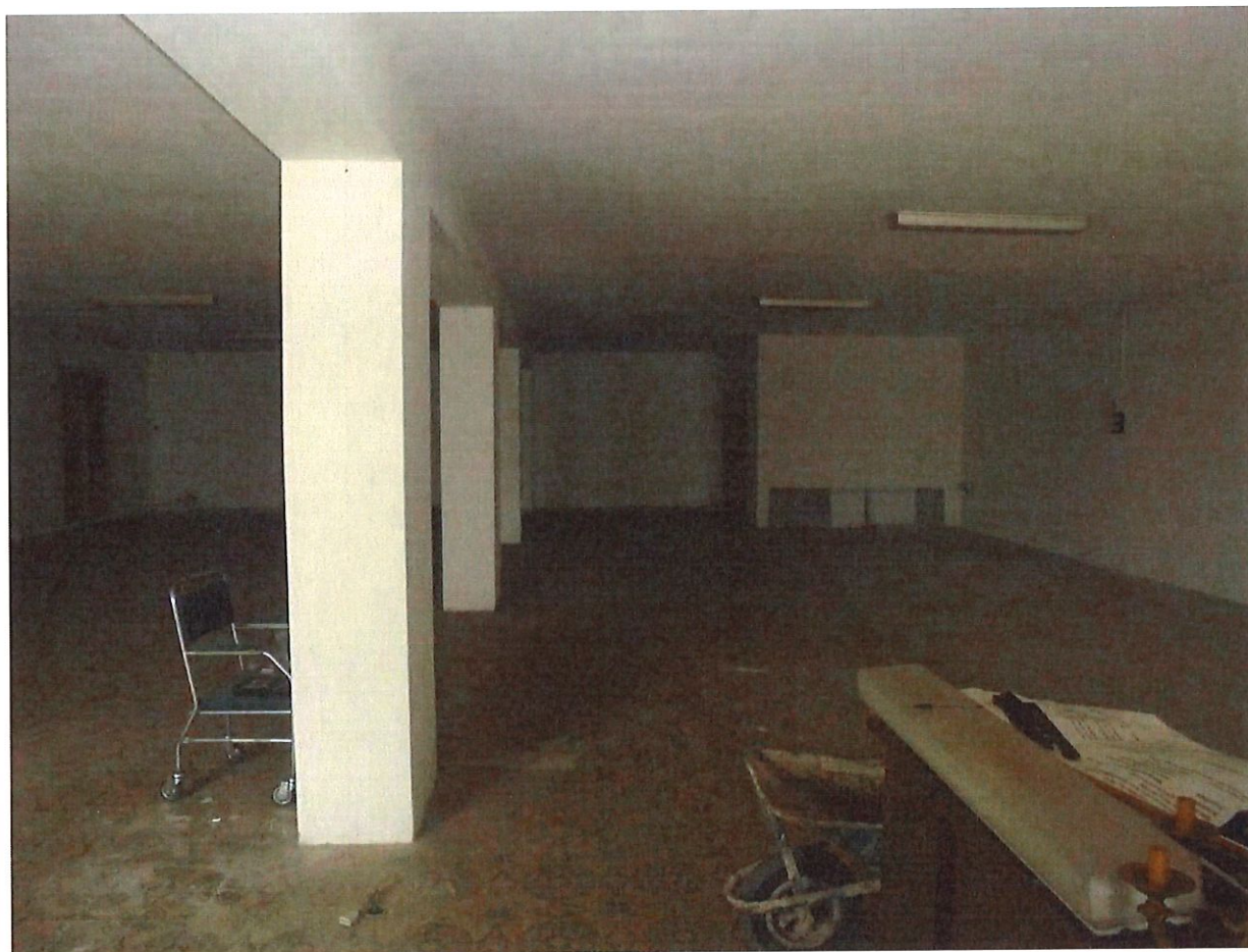
Foto 14. Magazzino – Piano terra. Particolare degli interni.
