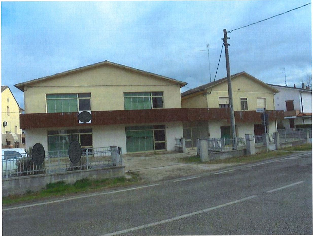
Foto 1. Prospetto Sud – Ovest. Vista da Via Provinciale.
