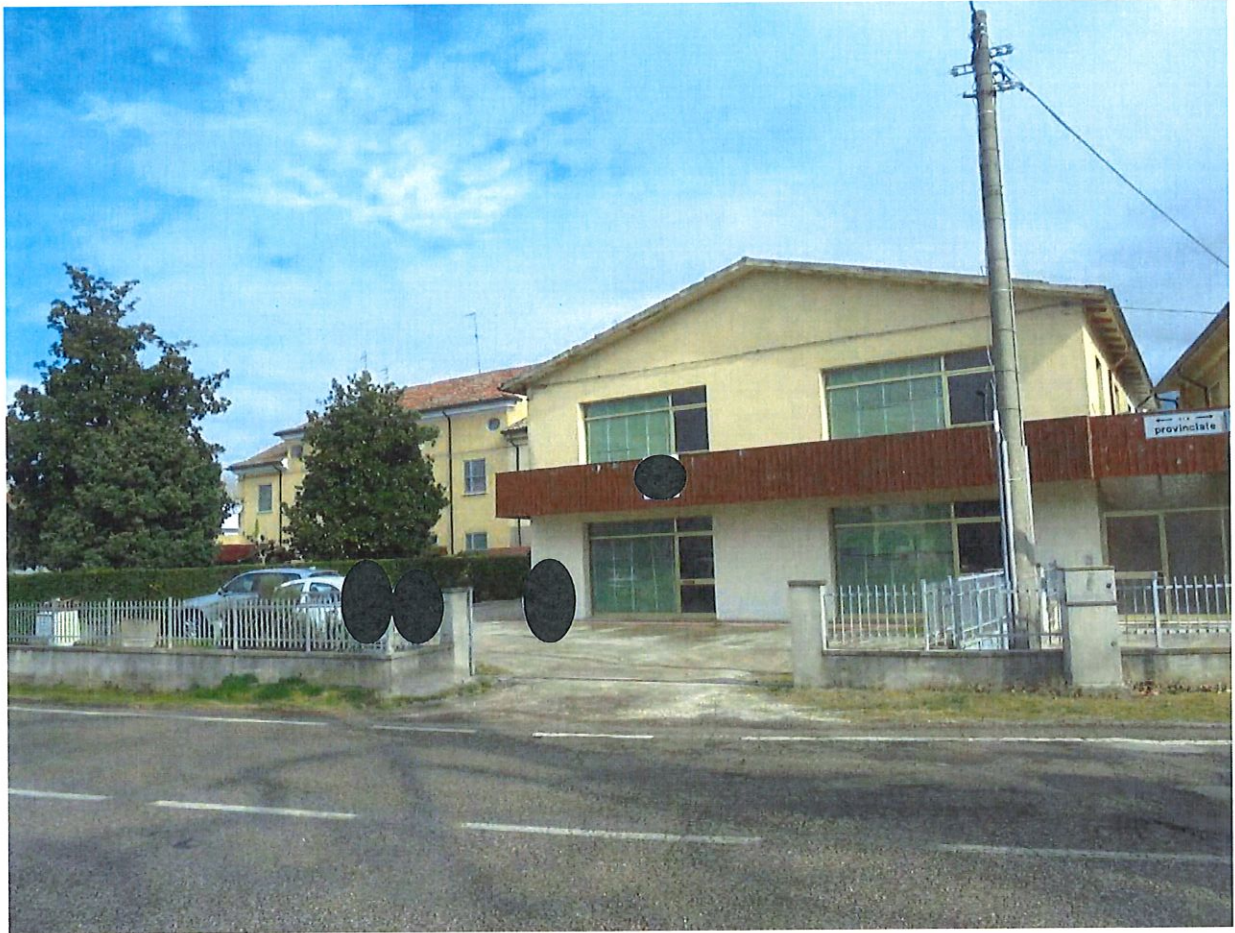
Foto 2. Prospetto Sud – Ovest. Vista da Via Provinciale.
