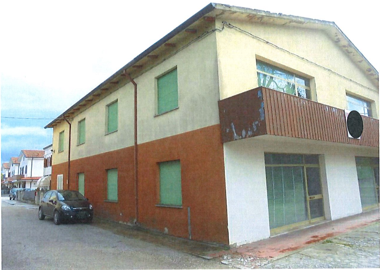
Foto 3. Prospetto Nord – Ovest. Vista da Via Provinciale.
