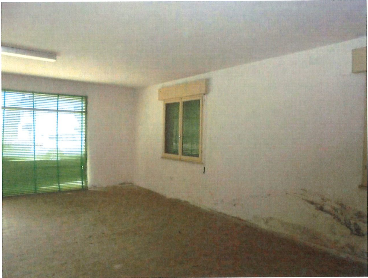
Foto 11. Magazzino – Piano terra. Particolare degli interni.
