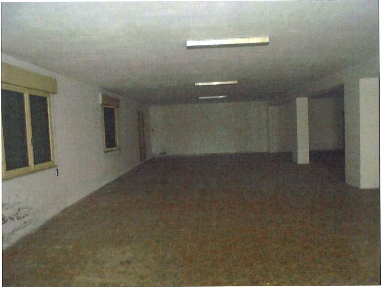
Foto 12. Magazzino – Piano terra. Particolare degli interni.
