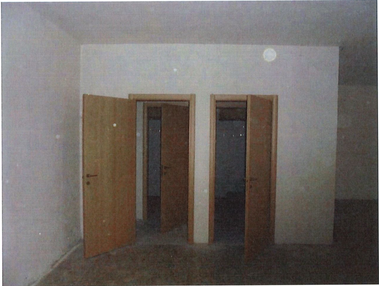
Foto 15. Magazzino – Piano terra. Particolare degli interni.
