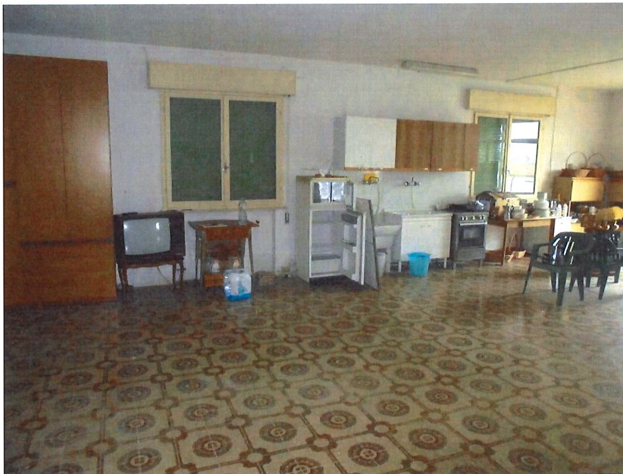
Foto 19. Magazzino – Piano primo. Particolare degli interni.
