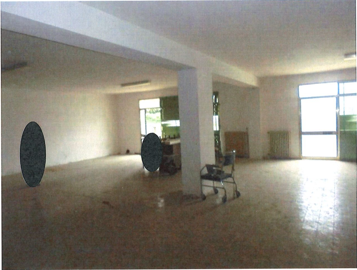
Foto 10. Magazzino – Piano terra. Particolare degli interni.
