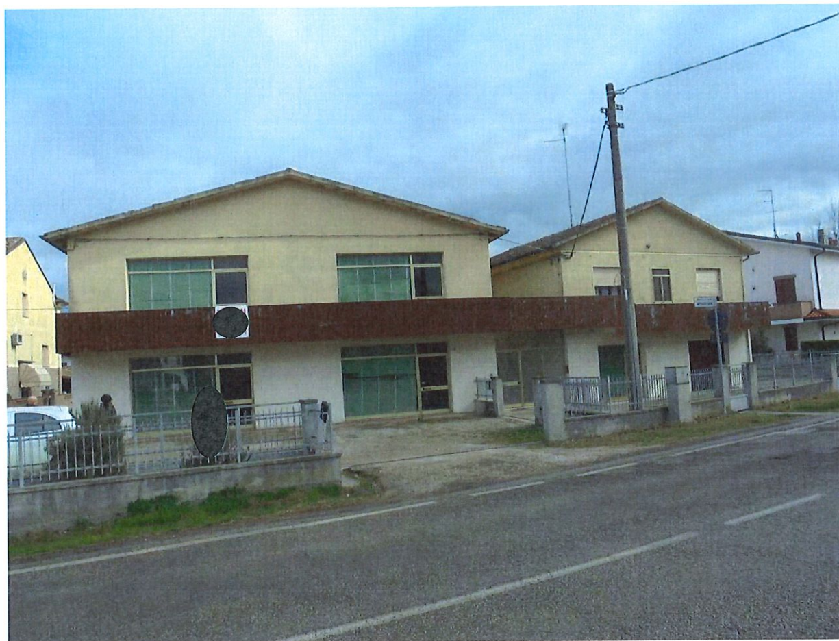
Foto 1. Ingresso – Ovest. Vista da Via Provinciale.
