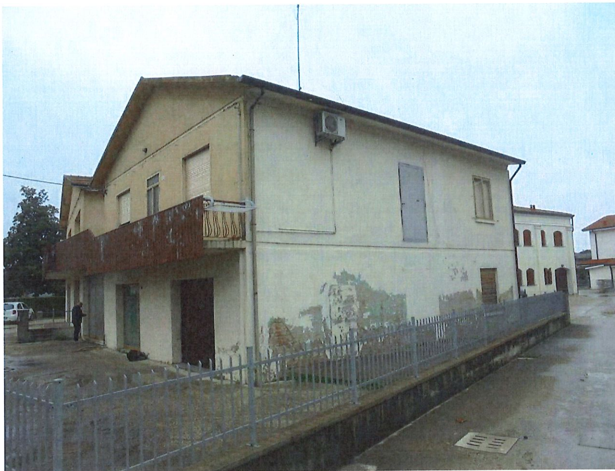
Foto 4. Prospetto Sud. Vista da passo carrabile.
