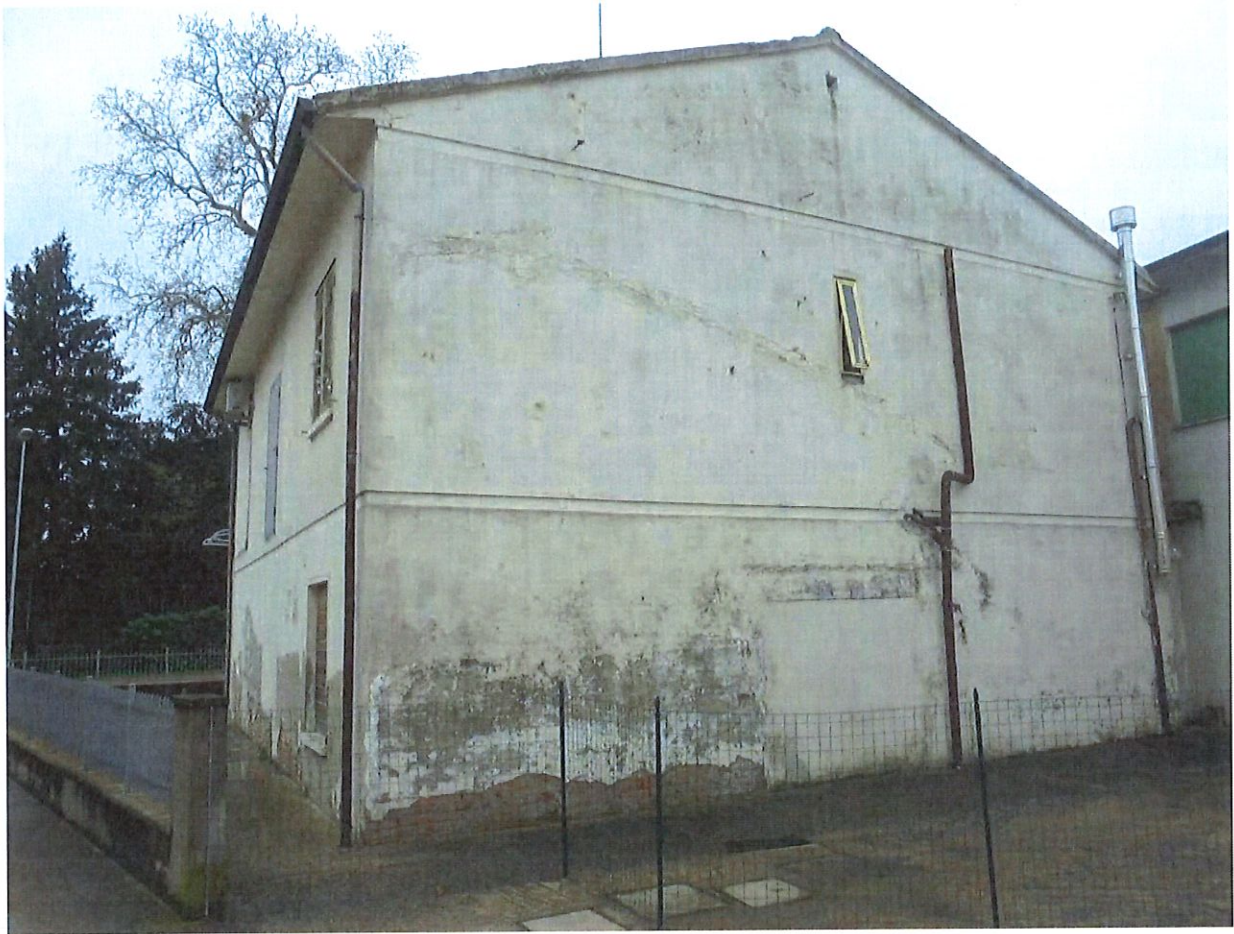
Foto 3. Prospetto Nord – Est. Vista da passo carrabile.
