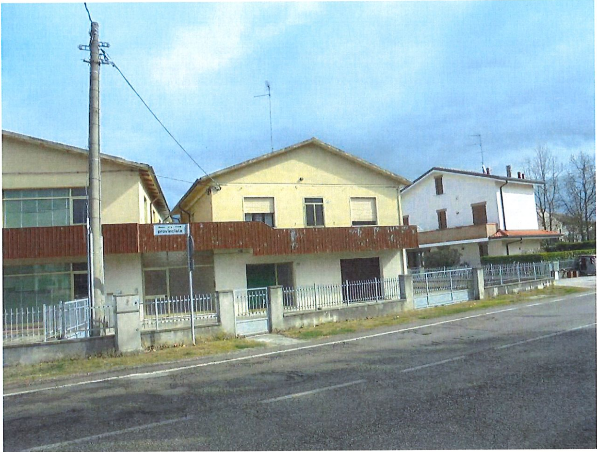
Foto 2. Prospetto Sud – Ovest. Vista da Via Provinciale.
