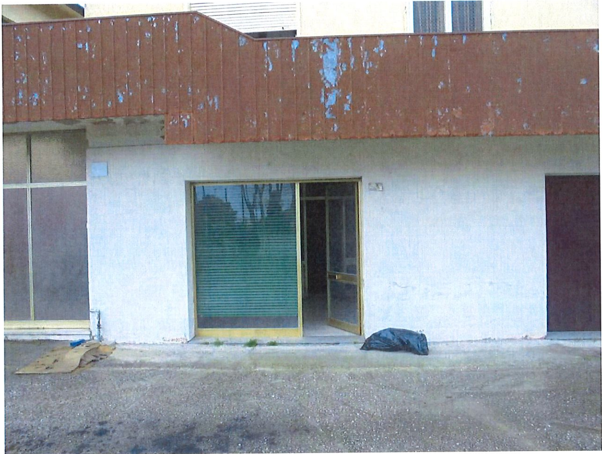
Foto 5. Prospetto Sud. Vista da passo carrabile.
