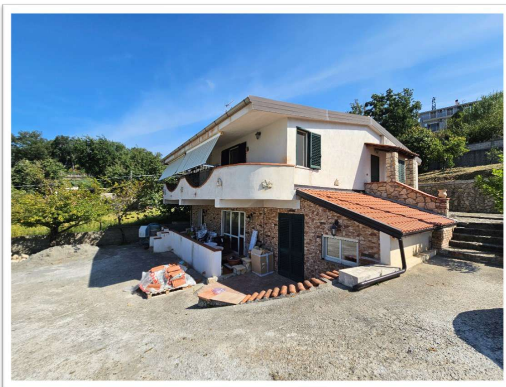
Foto 1 - Vista prospetto Sud/Ovest
