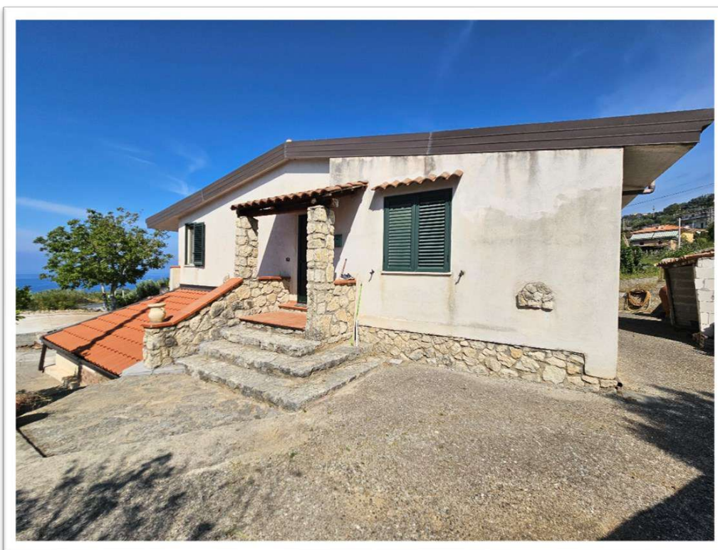
Foto 2 - Vista prospetto Sud
